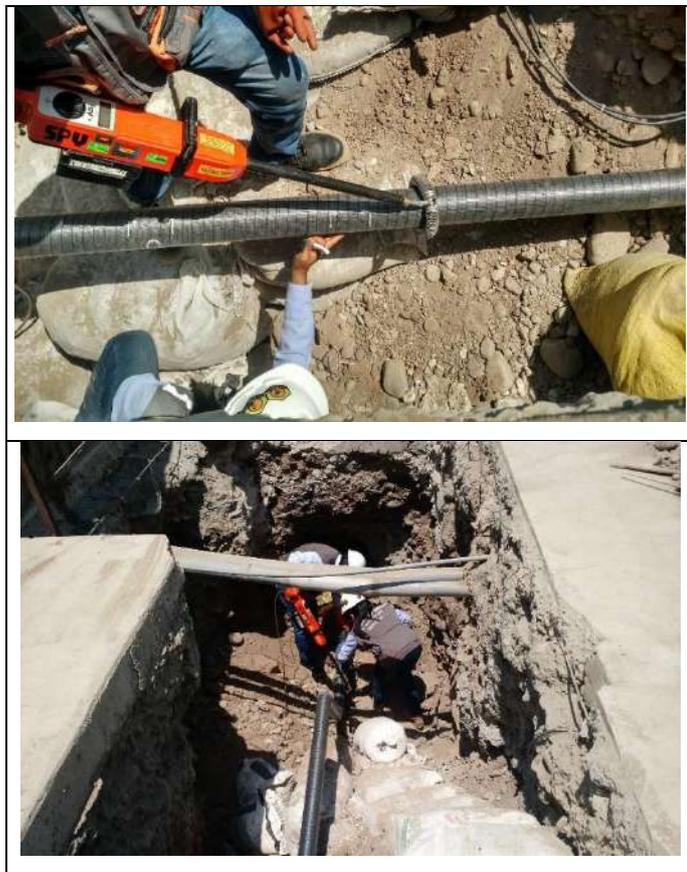
Nota: Holiday detector: es un dispositivo para localizar discontinuidades en un recubrimiento para lo cual genera un voltaje de alta tensión que busca generar un arco eléctrico en puntos de discontinuidad en el recubrimiento.
