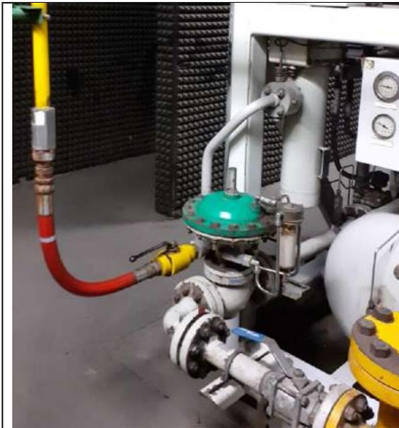
Válvula manual salida del compresor
