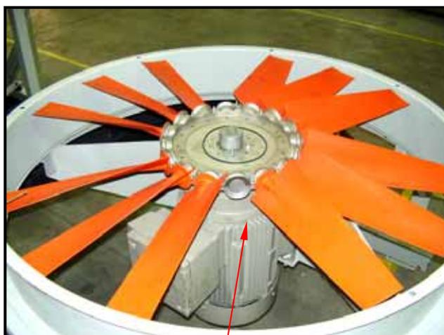
Motor eléctrico sistema aerofriador
