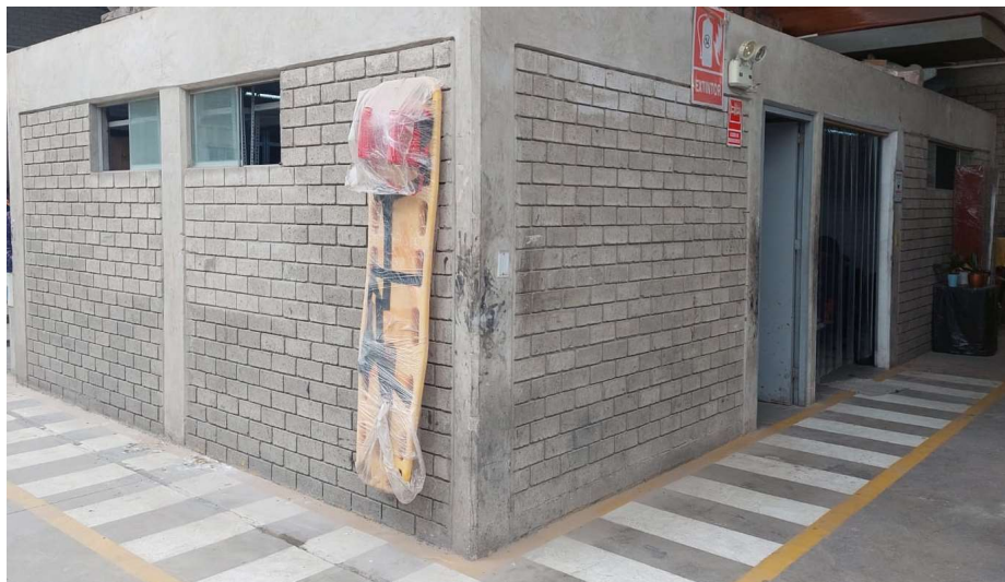
Figura 4.12 Nuevo almacén de equipos y herramientas
