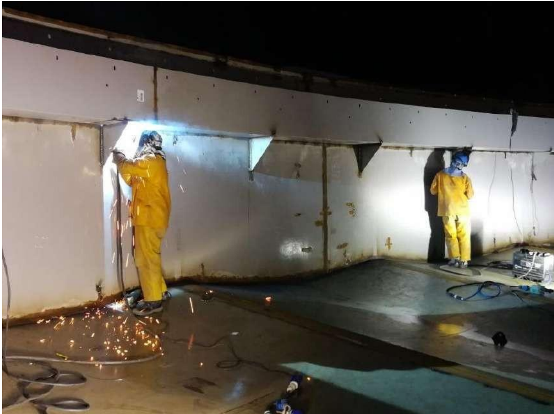
Figura 3.127 Soldadura de casco de espesador
