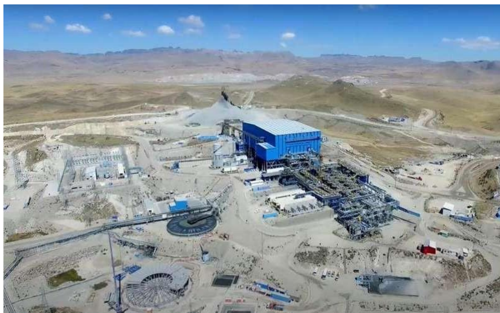
Figura 2.5 Vista panorámica de Antapaccay
