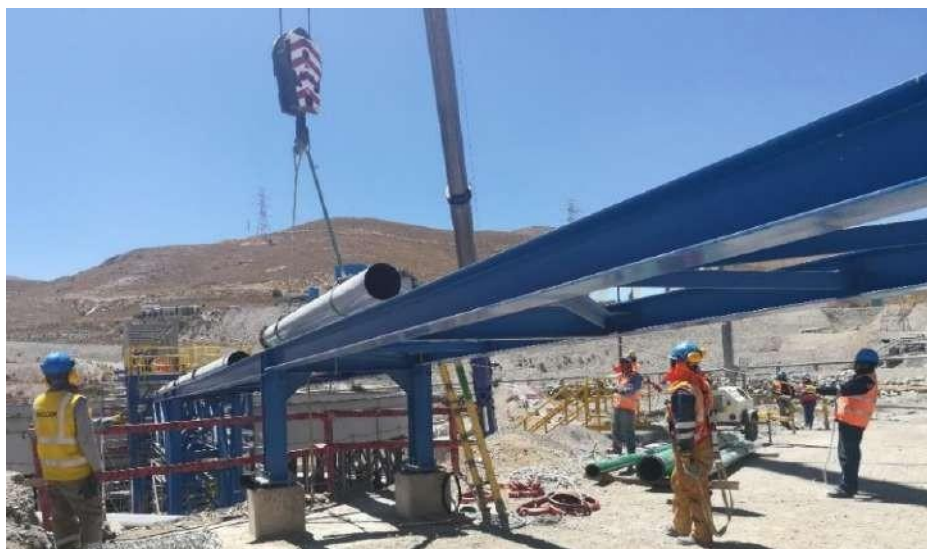
Figura 3.145 Montaje de soporte de tubería de alimentación
