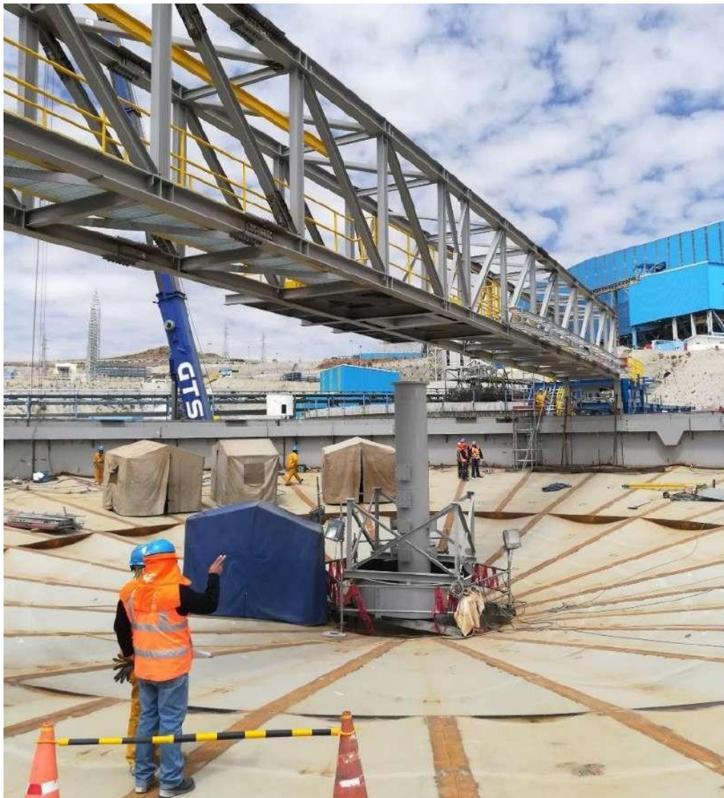
Figura 3.134 Montaje de eje
