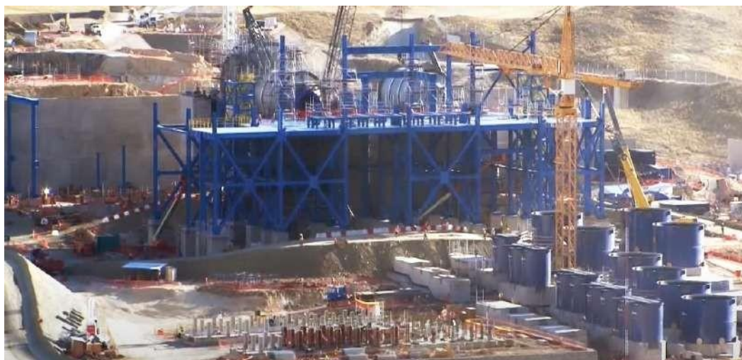
Figura 2.4 Construcción de planta concentradora
