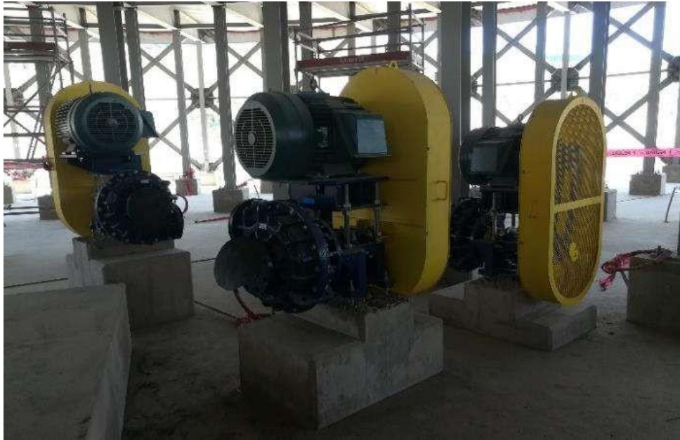
Figura 3.136 Montaje de bombas
