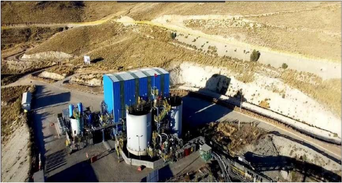
Figura 2.17 Área de filtros
