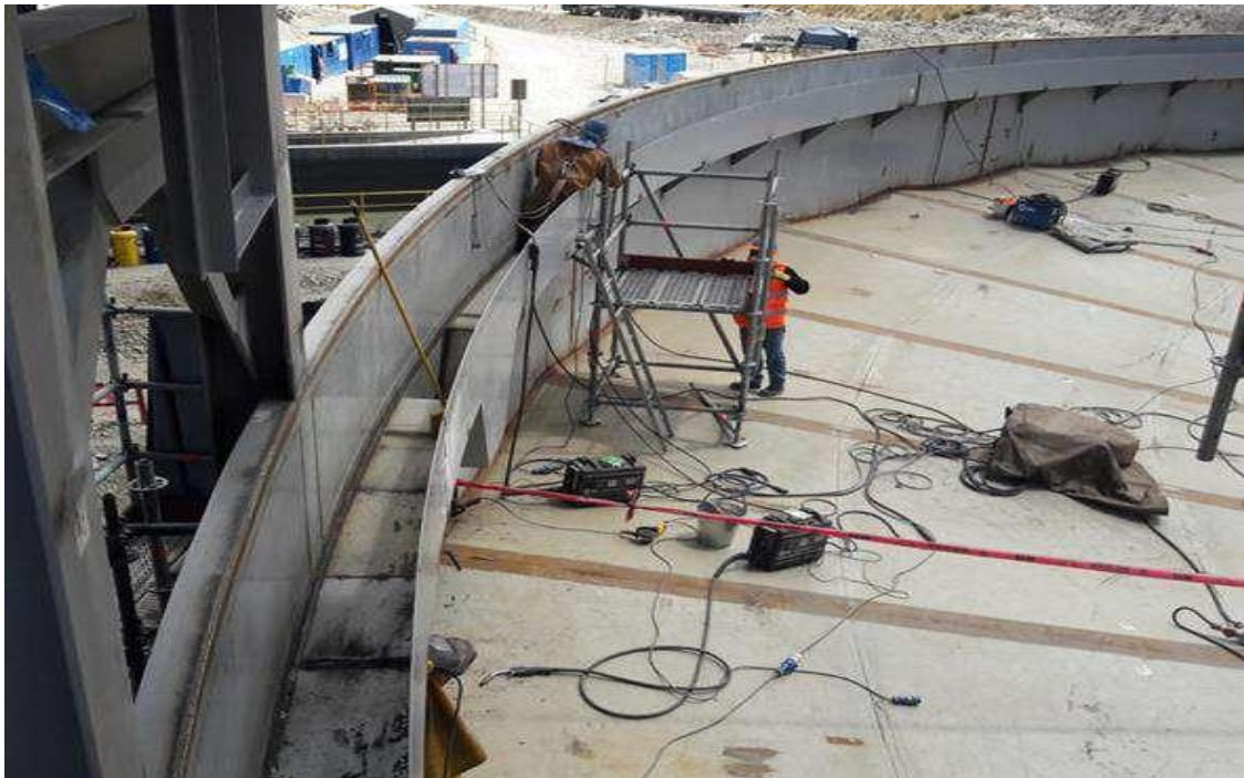
Figura 3.129 Soldadura de juntas de casco
