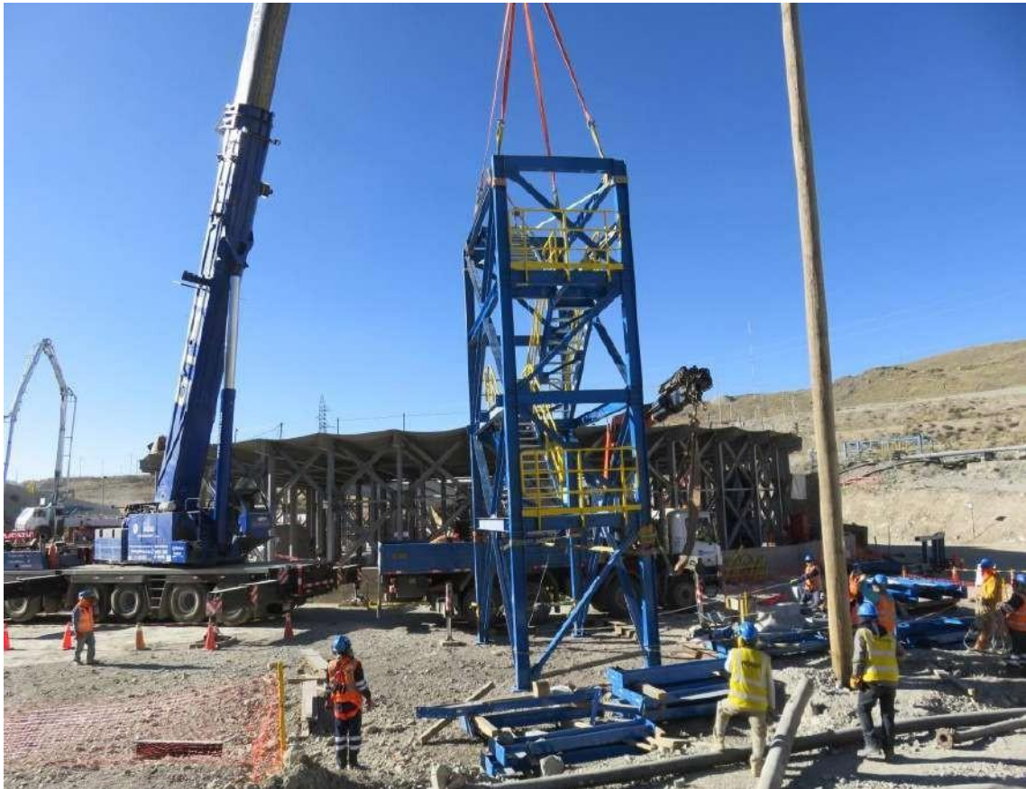
Figura 3.130 Detalle soporte de puente
