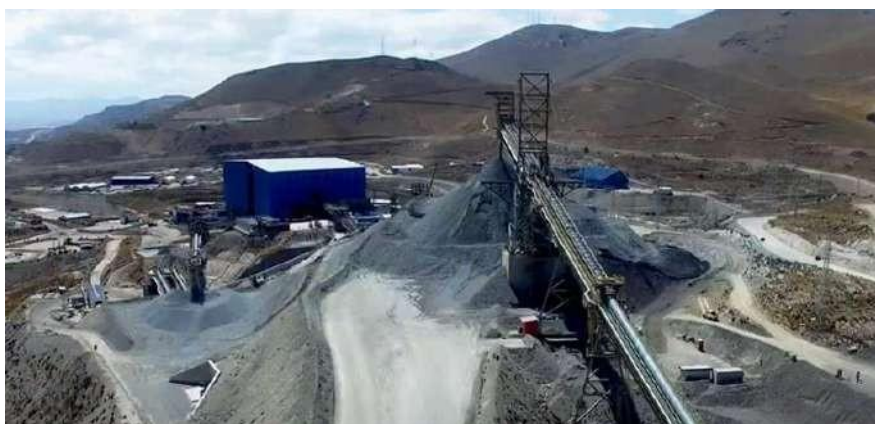
Figura 2.10 Vista trasera de faja transportadora
