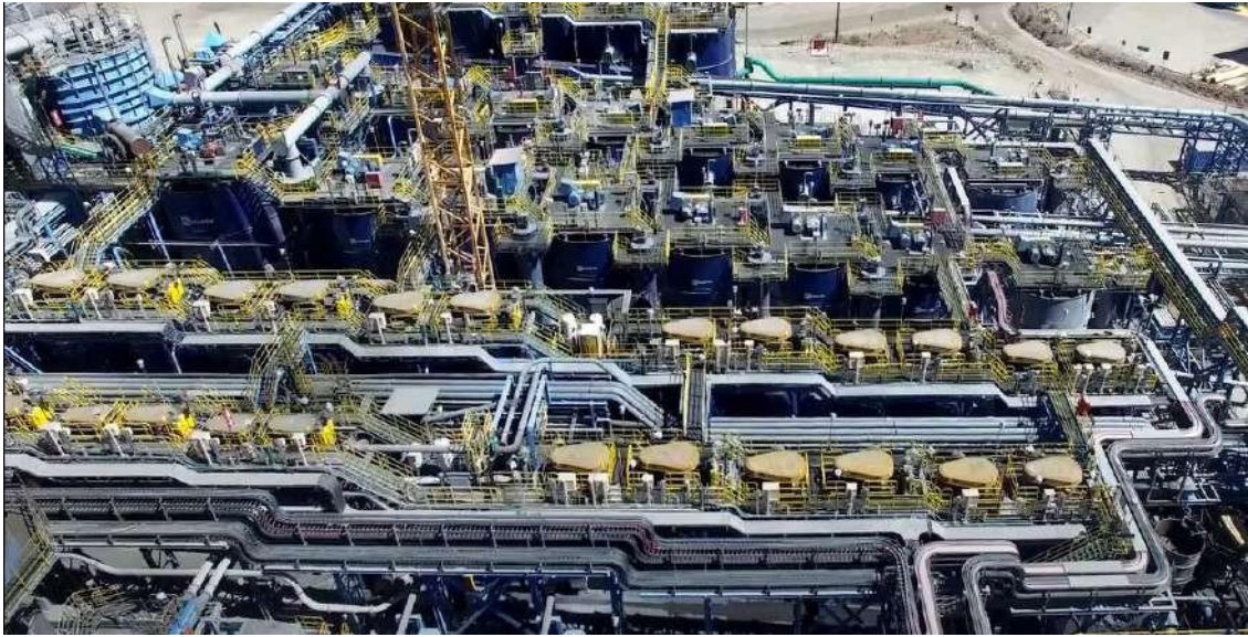
Figura 2.14 Vista de planta de circuito de flotación
