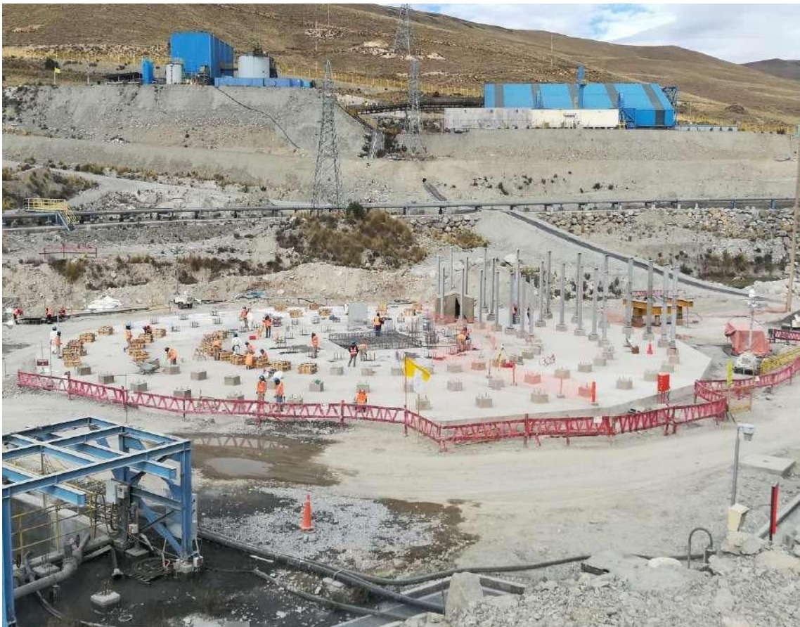
Figura 3.110 Montaje de columnas
