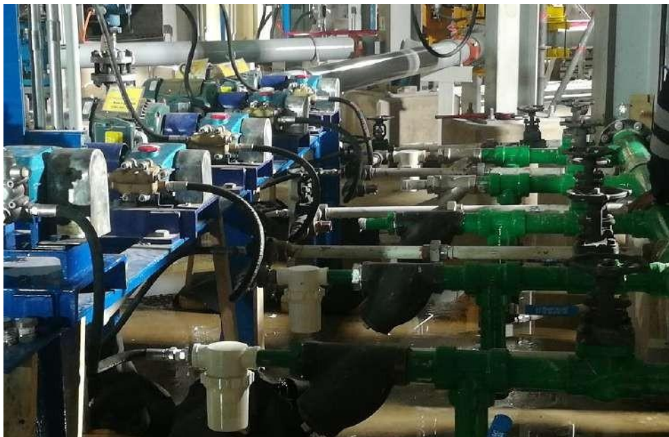
Figura 3.139 Montaje de circuito tuberías de agua de sello
