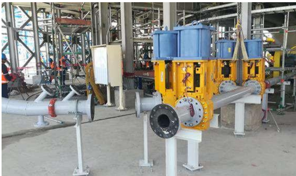
Figura 3.137 Montaje de tuberías de descarga y válvulas
