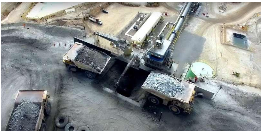
Figura 2.8 Deposito de materiales en chancadora primaria
