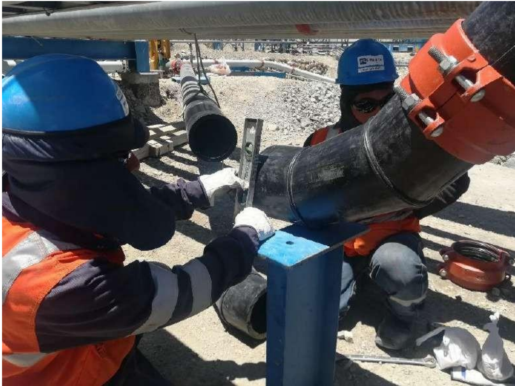
Figura 3.138 Montaje de tuberías de PVC y accesorios
