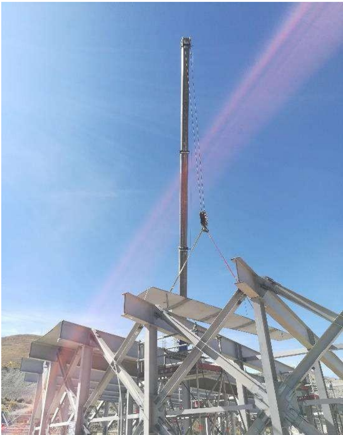
Figura 3.121 Montaje de planchas de fondo
