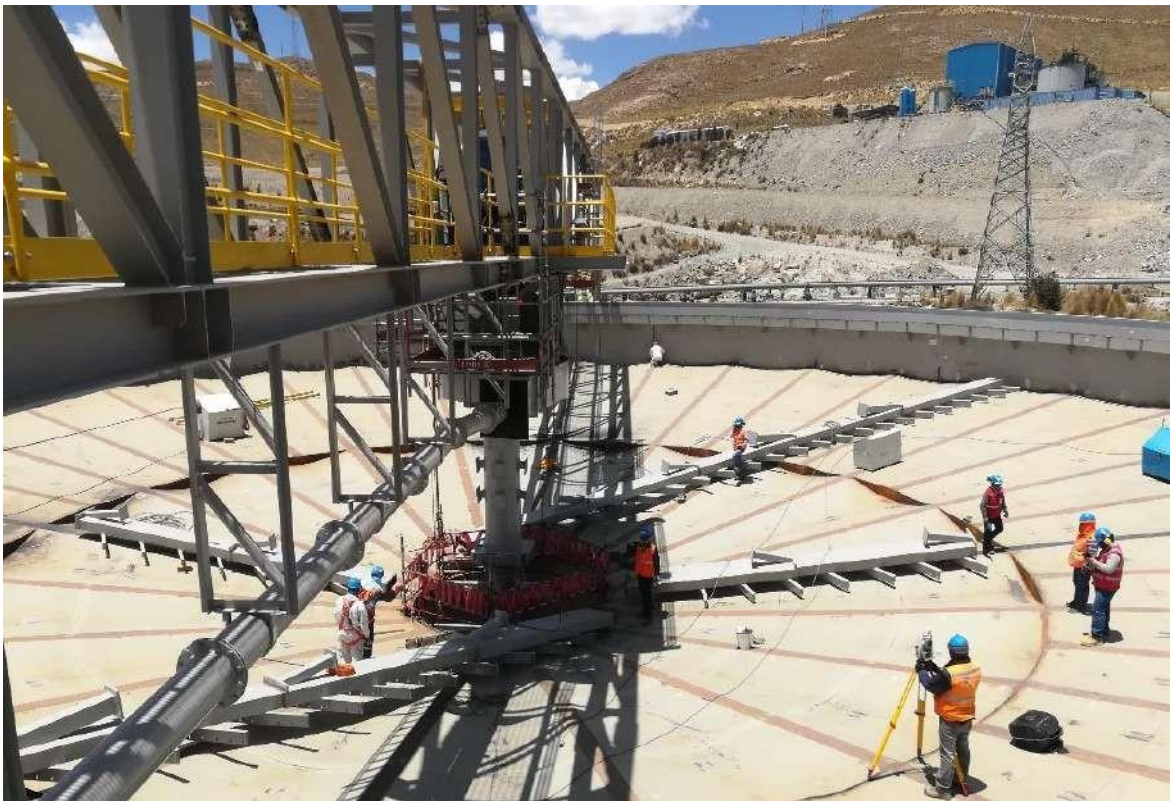
Figura 3.135 Montaje de rastras
