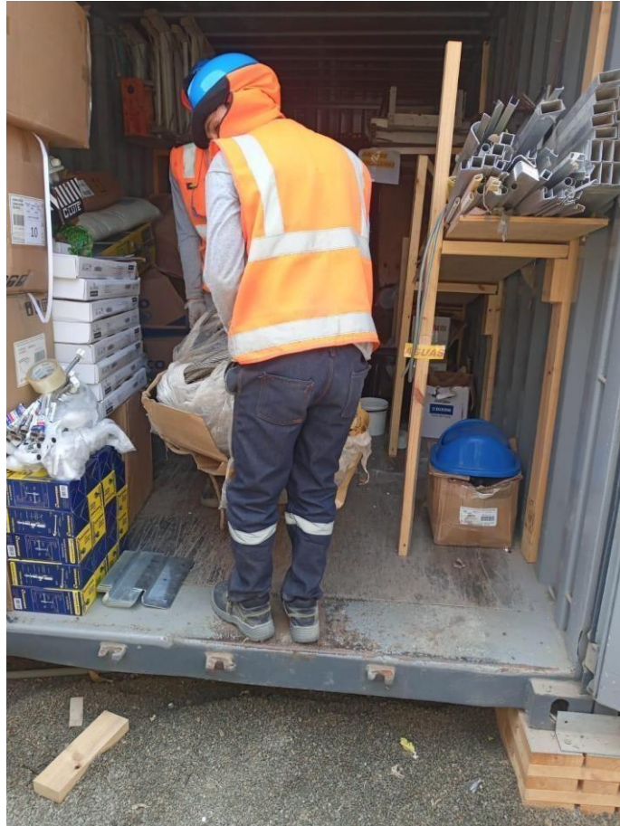
Figura N° 8: Retiro de desperdicios
