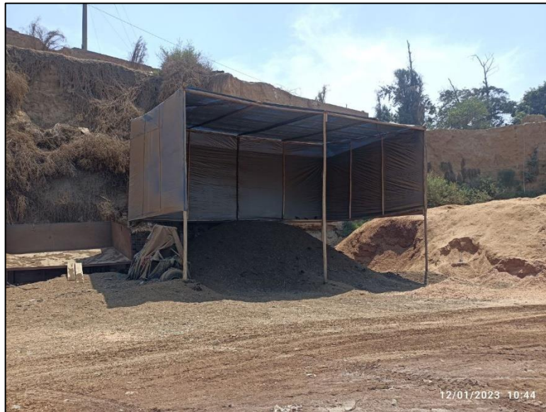
Fotografía 7. Encapsulamiento del área de materia
