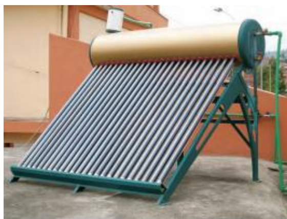
Figura 2.2 Calentador solar de tubos al vacío
