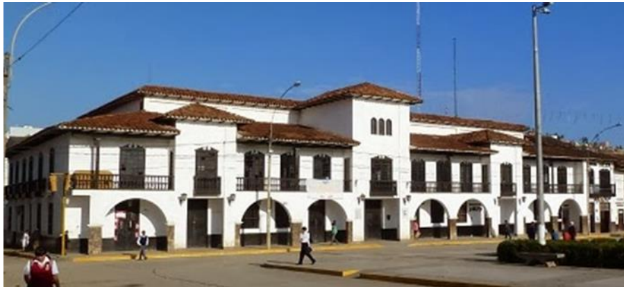
Figura 1. Municipalidad Provincial de Chachapoyas
