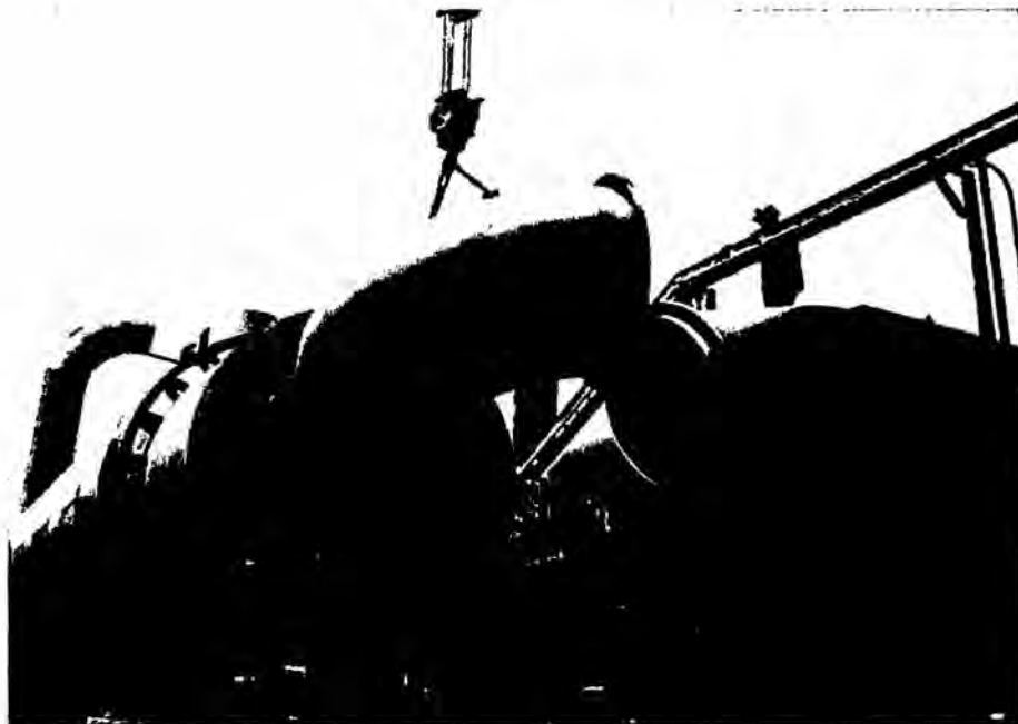
FIGURA 49. MONTAJE DE DUCTO DE INGRESO DE AIRE CALIENTE A CILINDRO SECADOR
