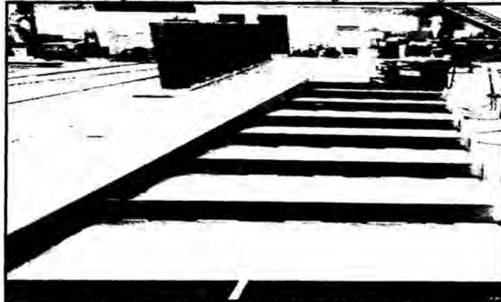
Figura N° 40.- Vista general de un tramo de viga con sus rigidizadores.
