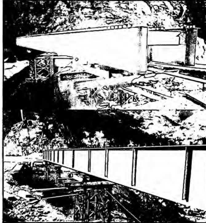
Figura N° 13.- Lanzamiento con apoyos intermedios.
