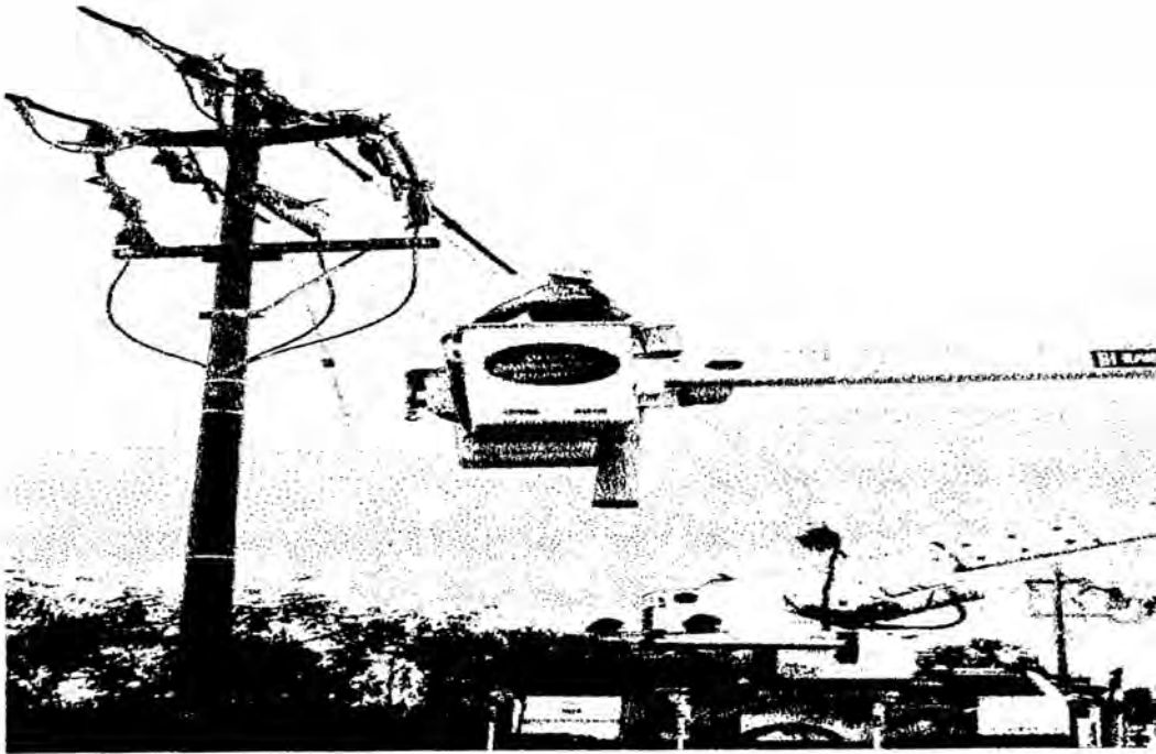
SOTERRADO DE CABLE M.T. DE RED AEREA A RED SUBTERRANEA
