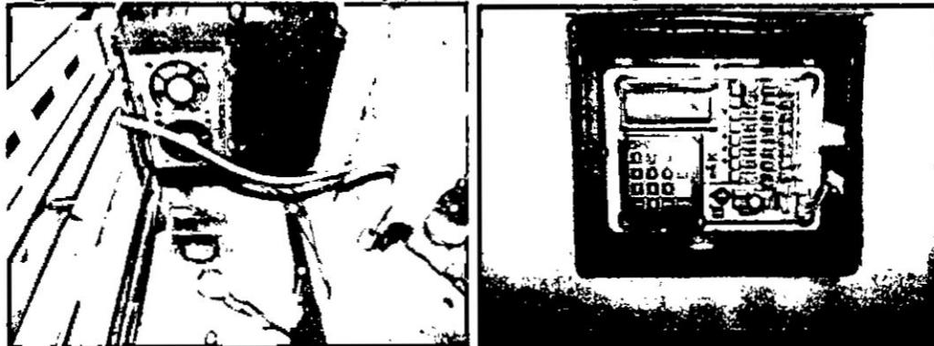
**Nota:** Vista que muestran la parte posterior de los tableros, obsérvese el transformador de 220v/12v para las válvulas de solenoide y el Cooler para enfriamiento de la tarjeta de control; mientras la segunda vista corresponde a tarjeta de control
