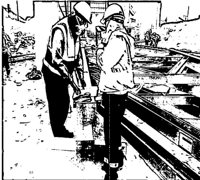
FIGURAN° 30: PRE MONTAJE DE CASTILLETE A NIVEL DEL SUELO
