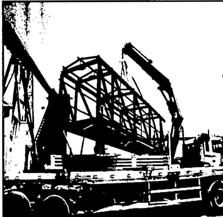
FIGURAN° 32: MOVILIZACIÓN DE GALERÍA A OBRA
