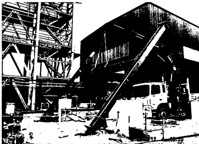
FIGURA N°21: MANIOBRA DE IZAJE CON CAMION GRUA
