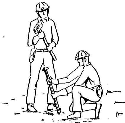
Operaciones previas para el tensado de conductores aéreos: preparación del puntero.
