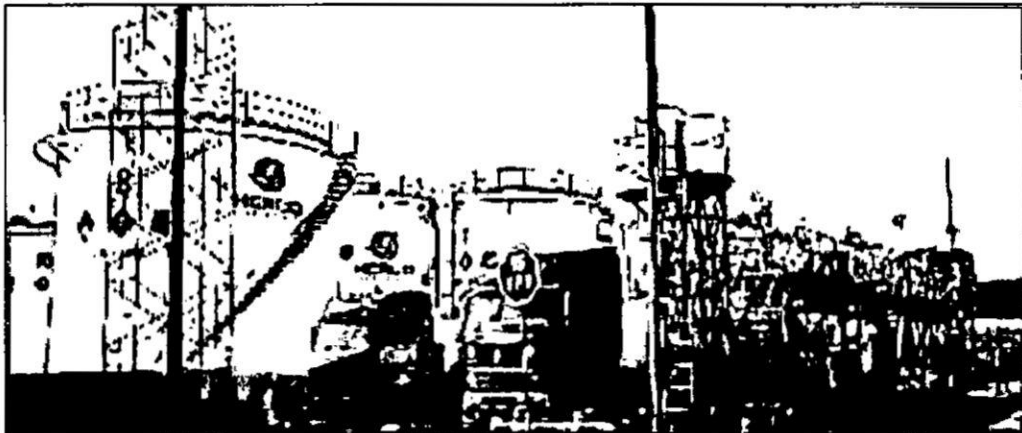
FIGURA N° 4.2 VISTA FRONTAL DE ZONA DE DESPACHO HERCO COMBUSTIBLES S.A.
