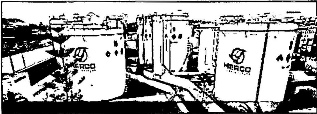
FIGURA N° 4.1 VISTA AEREA DE TANQUES DE ALMACENAMIENTO HERCO COMBUSTIBLES S.A.
