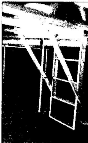
Figura 4.25 INSTALACIÓN DE ESCALERA TIPO GATO
