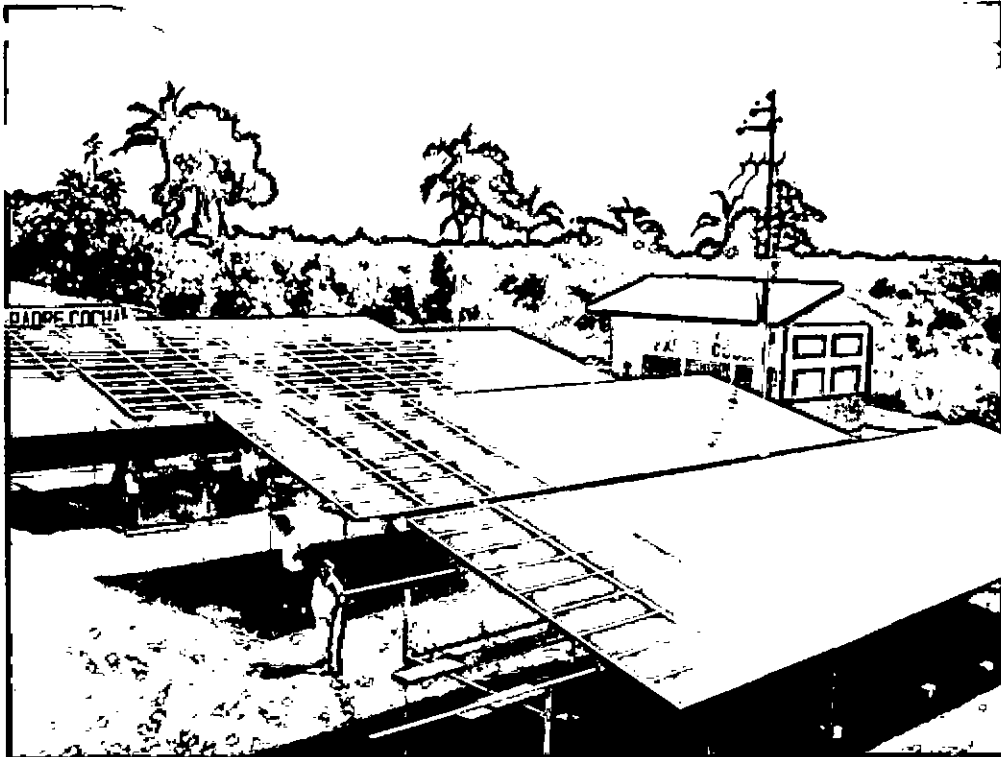
Fig. N° 4.3: Sistema híbrido Solar fotovoltaico y Diesel instalado en la localidad Padre Cocha.
