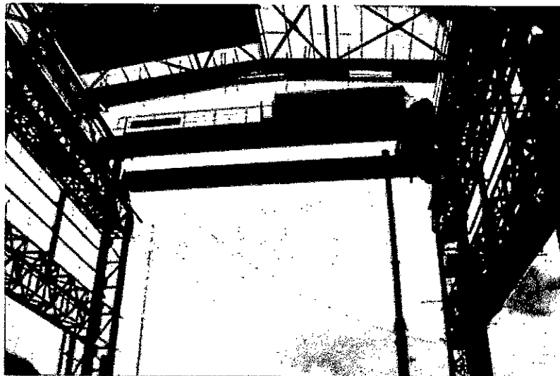
Figura 44: Torqueo de puente grúa de 35ton tag 150-cnb-607 35/5
