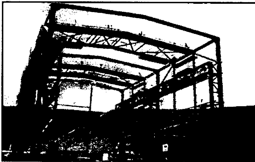
Figura 37: Torqueo de vigas de techo
