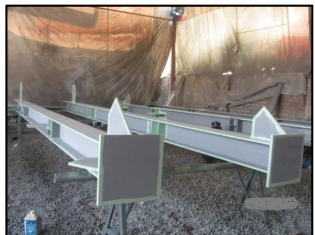
INSPECCIÓN DE LA CAPA REFUERZO
