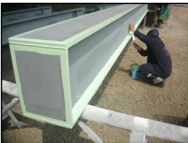
APLICACIÓN DE LA CAPA REFUERZO
