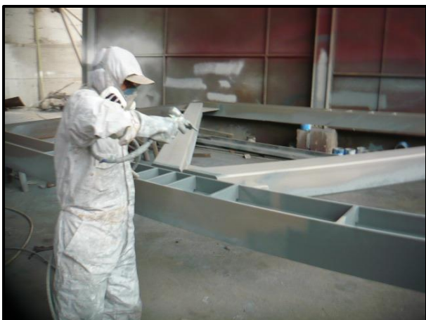
APLICACIÓN DE PINTURA A UN ENREJADO
