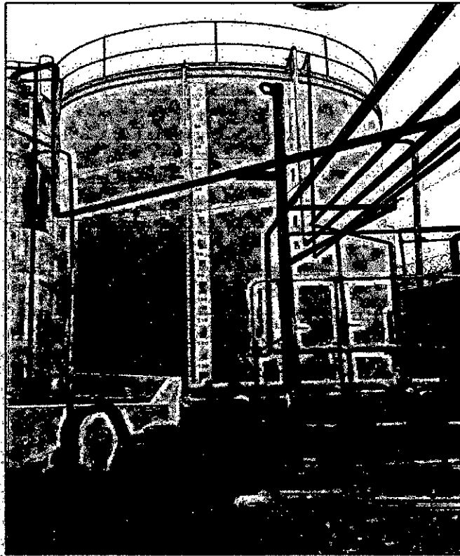
IMAGEN 2. 3: TANQUE DE AGUA 40 M3
