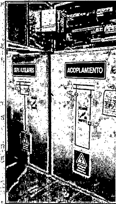
Figura N°.57: Subestación Eléctrica Gálvez
