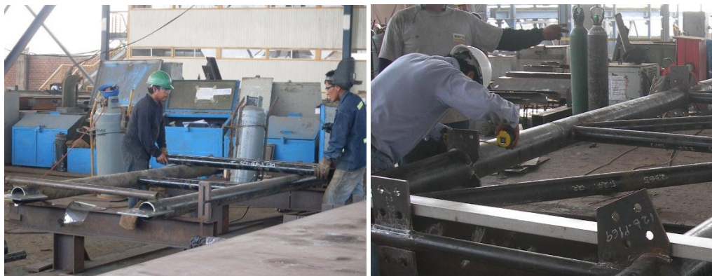
Fig. N°4.16 Inspección de armado y apuntalado
