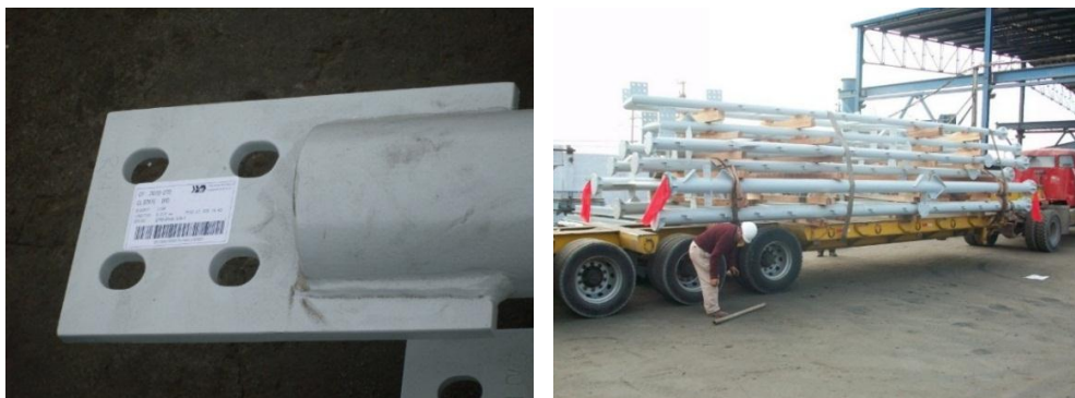
Fig. N° 4.36 Estructuras codificadas y empaquetadas para llevar a obra. Fuente: Propia
