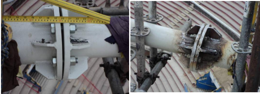
Fig. N° 4.22 Correccion de brida a su posicion correcta.
