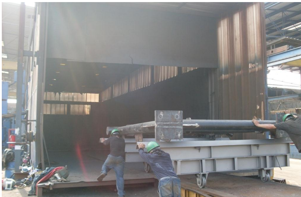
Fig. N° 4.32 Ingreso de estructuras a cabina de granallado
