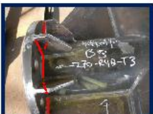
FOTO 5: Se observa los tramos de la Brida 3, Inspeccionado mediante partículas magnéticas vía seca, los cuales no presentan discontinuidades relevantes.
