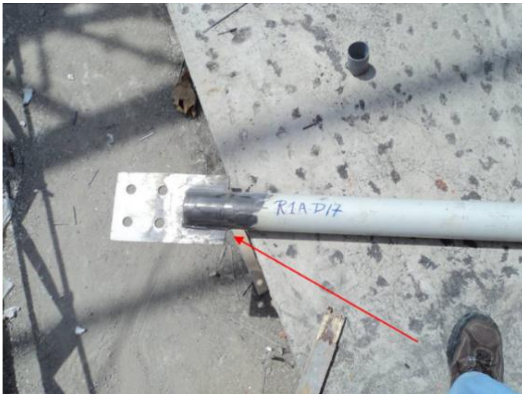
Fig. N° 4.23 Reparación de cartela de diagonal a su posición correcta
