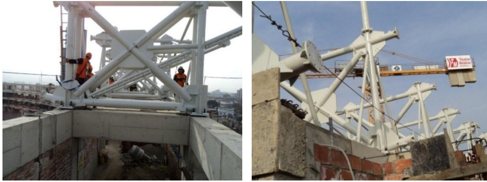
Fig. N° 4.37 Estructuras montadas en obra según codificación.
