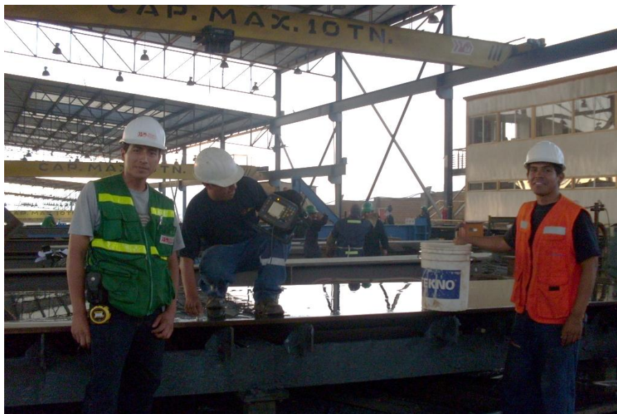
Fig.N°4.5 Inspección de Ultrasonido para descartar laminación
