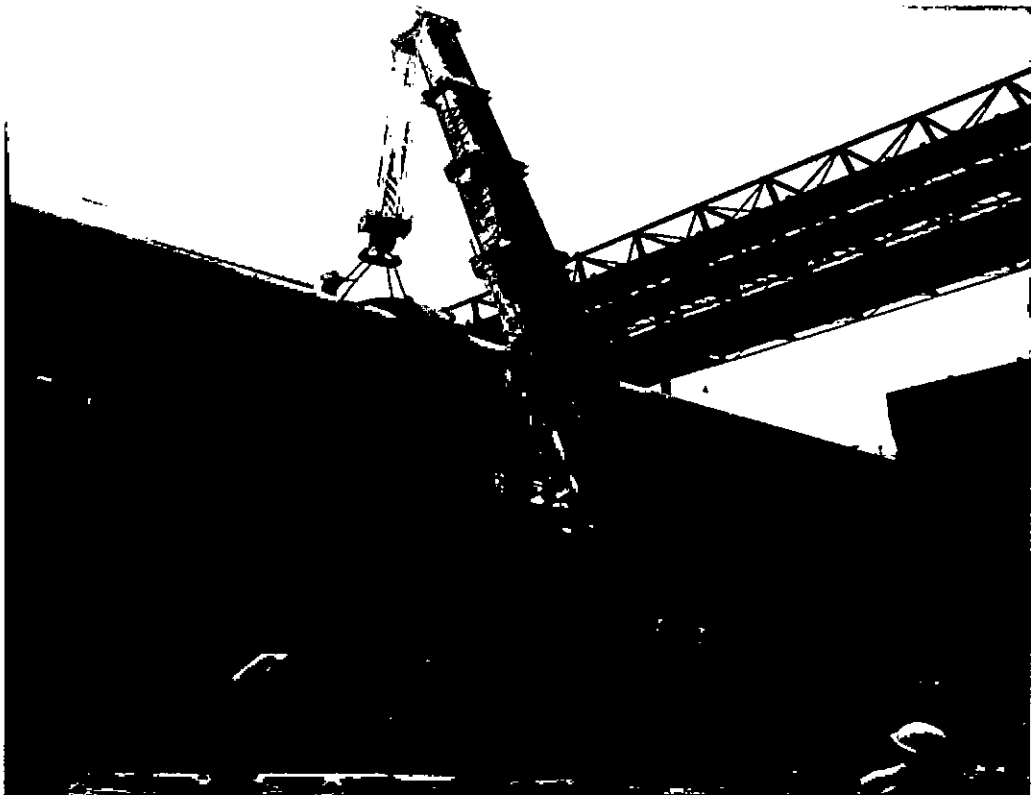
Figura N° 18: GRUA DE 650 TN. EN POSICION PARA CORTE DE VIROLA II CON LLANTA INCLUIDA
