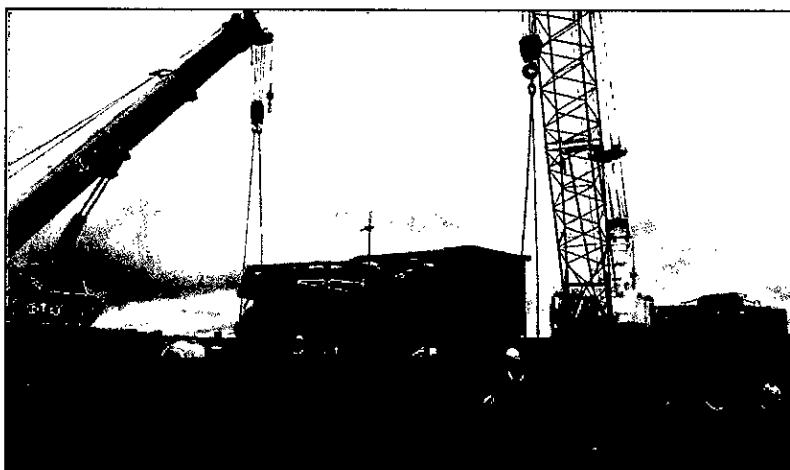
Figura 4.6.2: Descarga de Chasis
