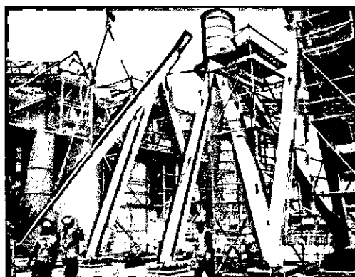
Montaje de Columnas Pendulares.
