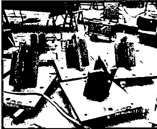
Armado de planchas bases T1 y T2.
