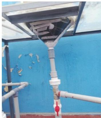
*Figura 53. Recirculación de lodos*
