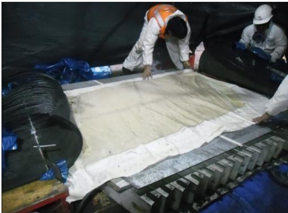
Figura N° 11: Instalación de equipos
