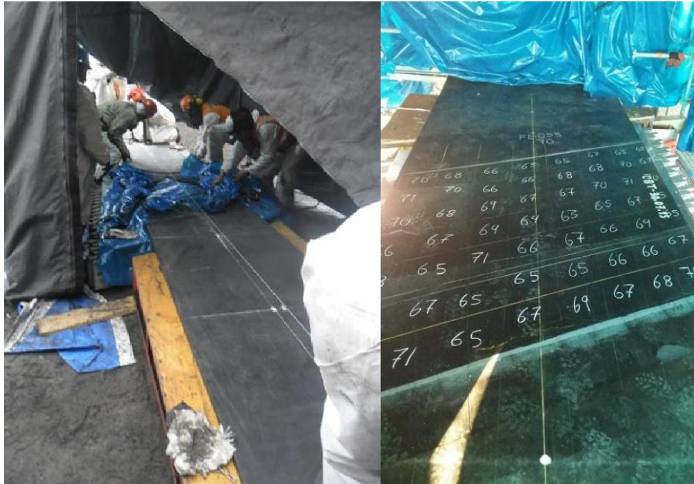
Figura N° 12: Trazos para el alineamiento de puntas
