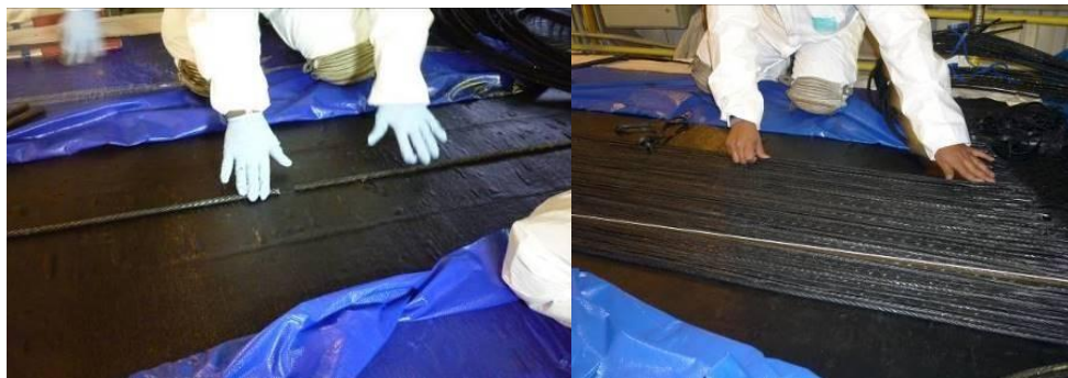
Figura N°22: Alineación de los cables de empalme
