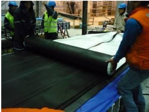
Figura N°23: Instalación del cover
