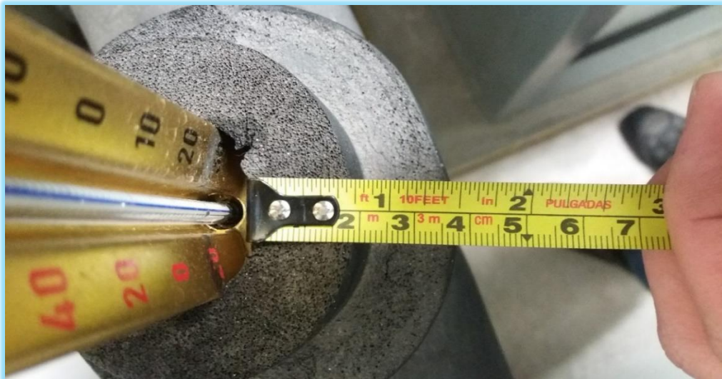
Figura N°4.10 TUBERIA CON ESPUMA ELASTOMÉTRICA
