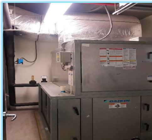
Figura N°4.5 UNIDAD MANEJADORA DE AIRE (UMA)
