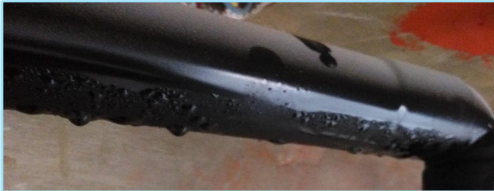
Figura N°4.9 TUBERIA SIN ESPUMA ELASTOMÉTRICA
