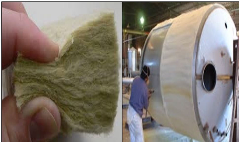
Figura 2.8: Aislamiento de una caldera pirotubular
