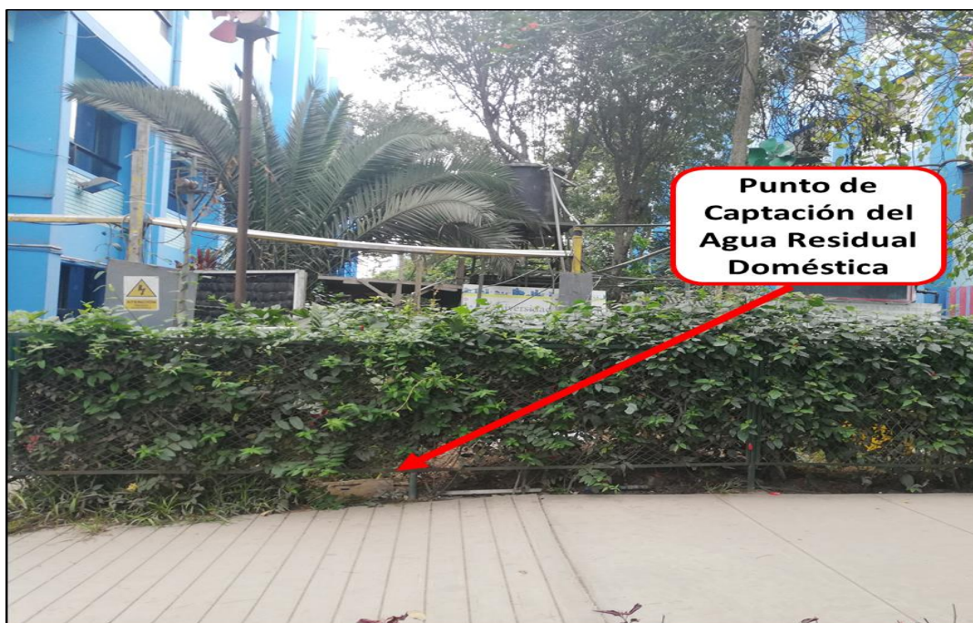
Figura N° 1: Ubicación del punto de captación del Agua Residual Doméstica
