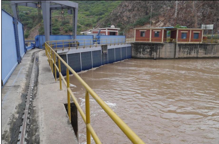
Foto 1. Bocatoma Raca Rumi que permite captación del río Chancay hacia Reservorio Tinajones. Cuenca Chancay –Lambayeque.
