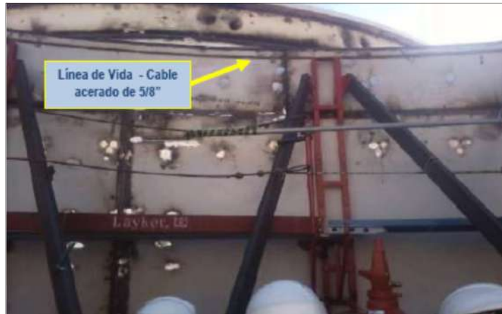
Figura 23 Detalle de línea de vida.
