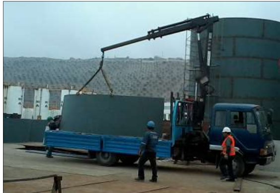
Figura 25 Camión Hiab cargando planchas.
