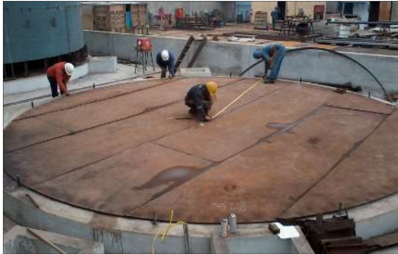
Figura 19 Montaje de planchas de fondo.
