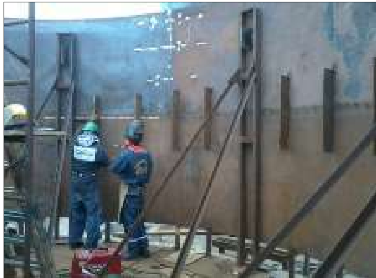
Figura 29 Apuntalamiento de planchas guía.
