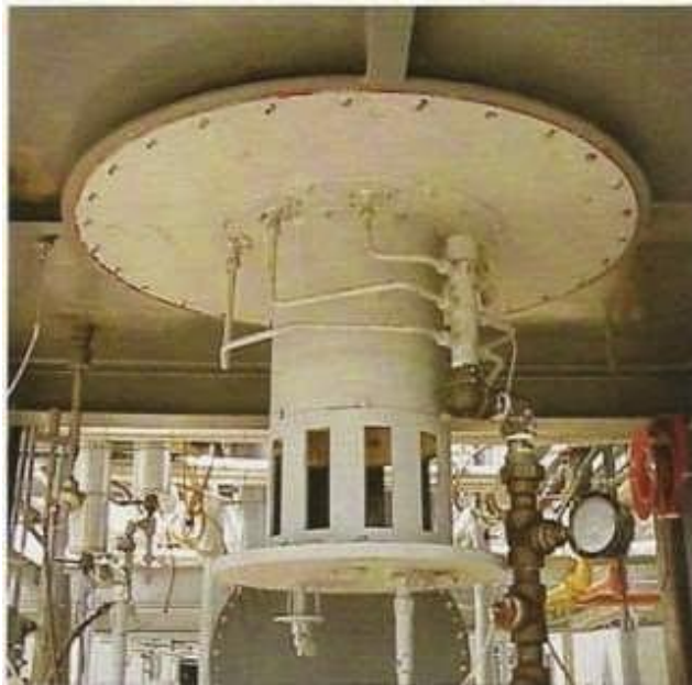
Fig. N° 24: Quemador de gas combustible de tiro natural Fuente: The John Zink Combustion Handbook.
