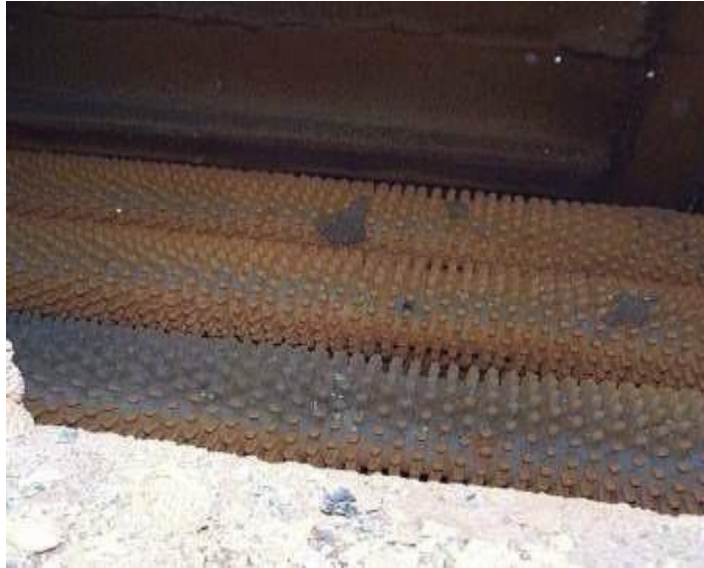
Fig. N° 20: Tubos entetonados -Stud tubes en uso Fuente: UOP Honeywell Company. Fired Heaters 2008.
