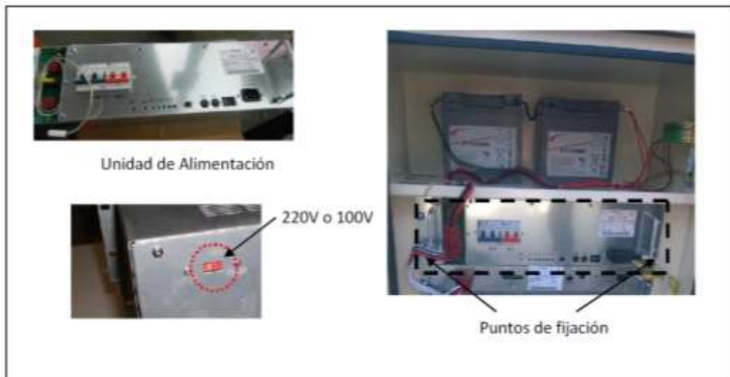
Figura N° 11 - Instalación de UP
