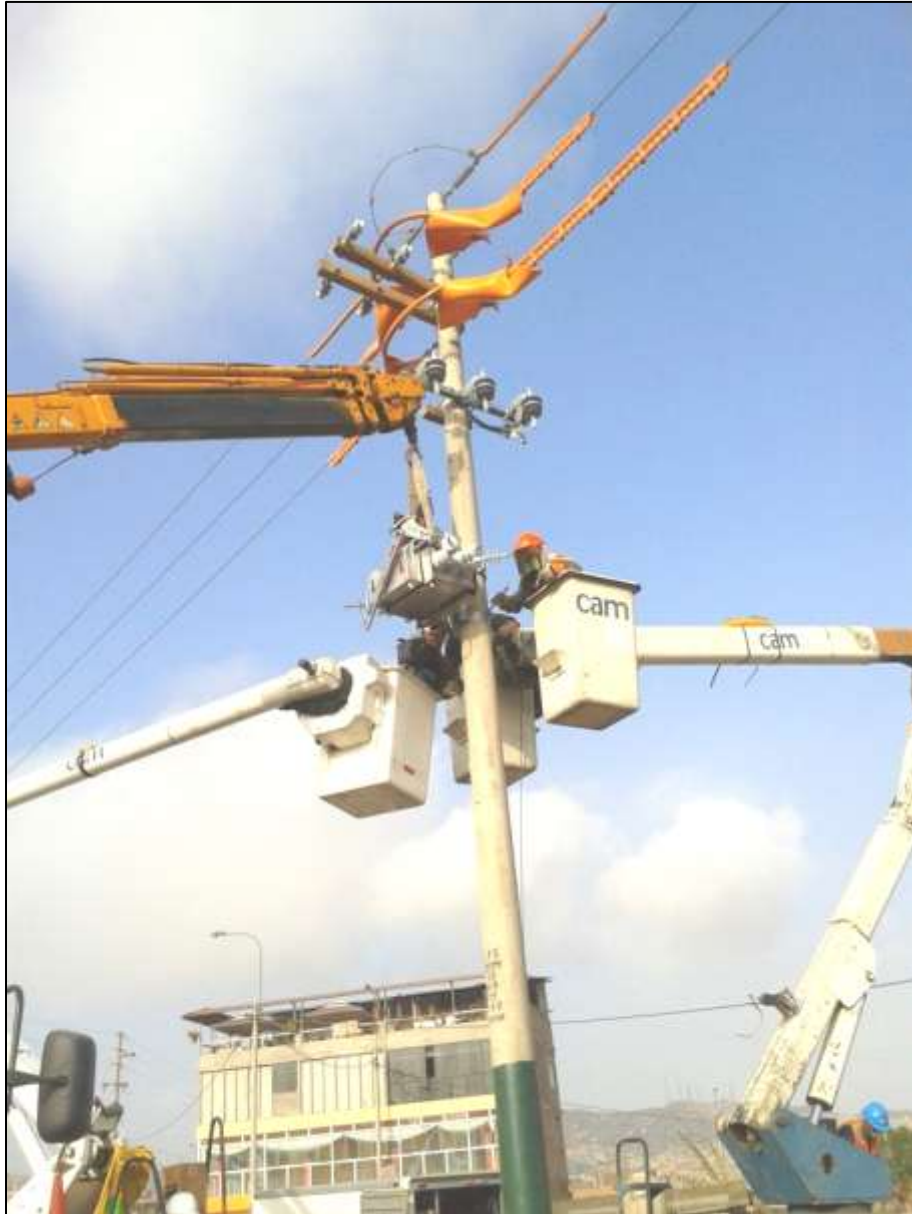
Figura N° 4 - Unidad de Líneas Energizadas instalando un SBC
