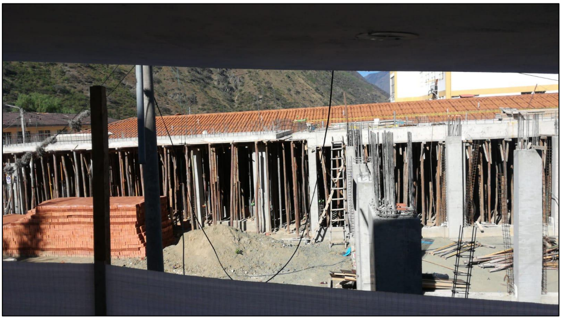
Construcción de la infraestructura para Imagenología- Tomografía
