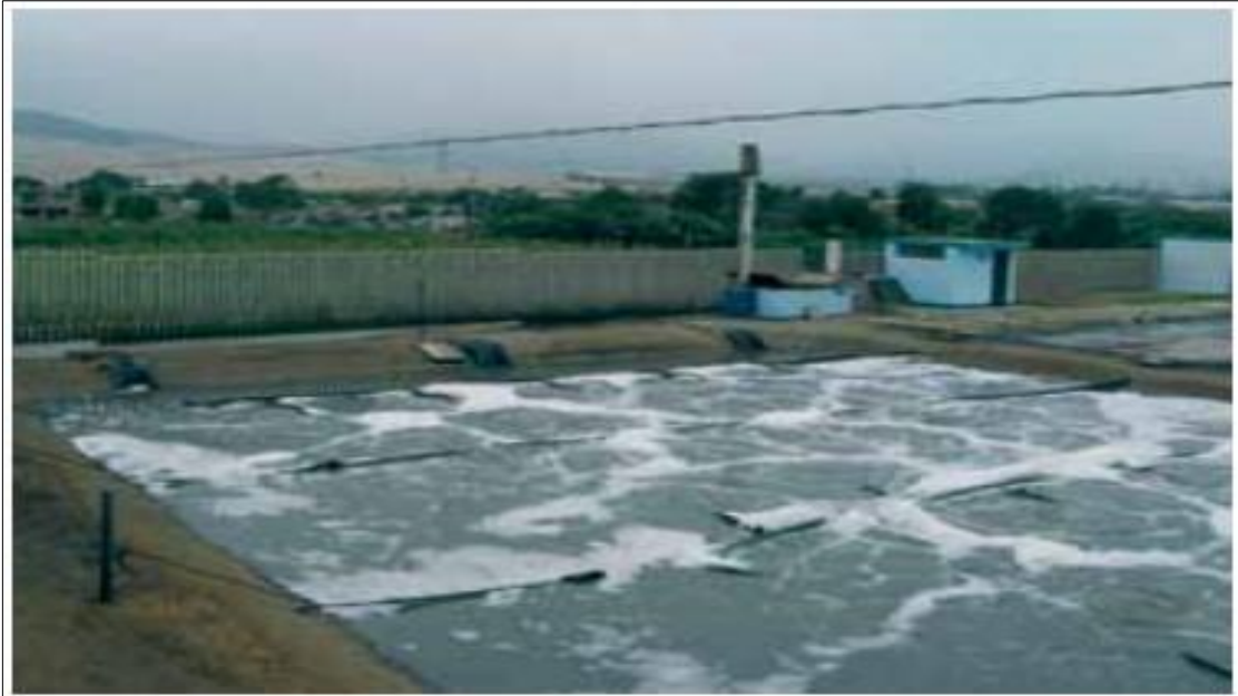
Sistema de lagunas aireadas
