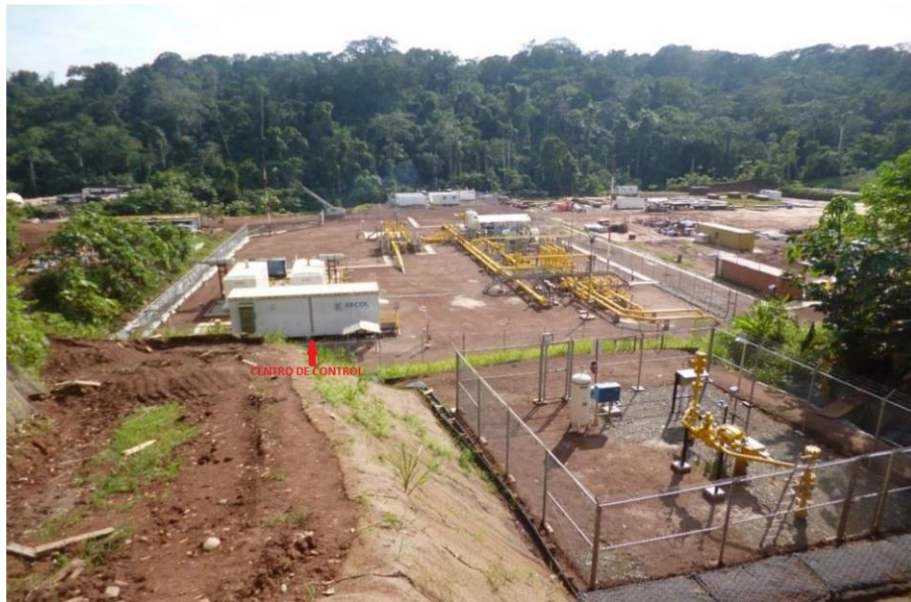
Figura 1. Estación Mipaya en construcción
