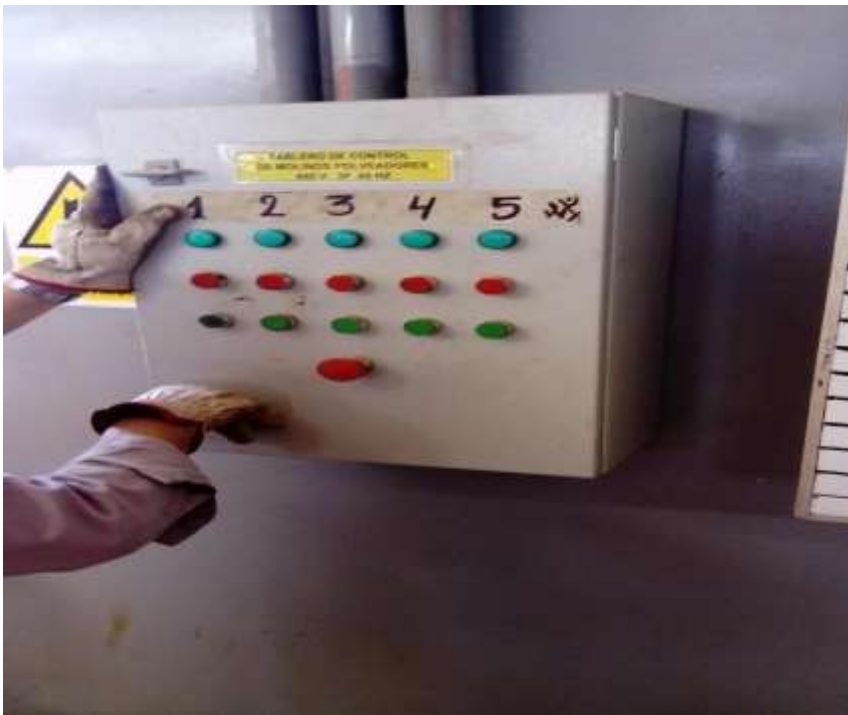
Figura 18: Mantenimiento de Panel Eléctrico- Trabajos en Alta Tensión Portal Koricancha Joint Venture
