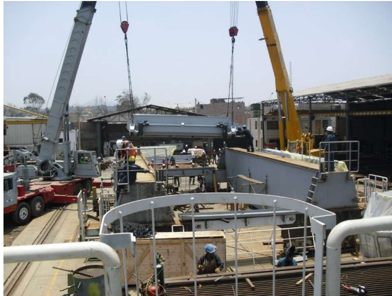
Ilustración 2.2.6 Montaje de vigas cajón
