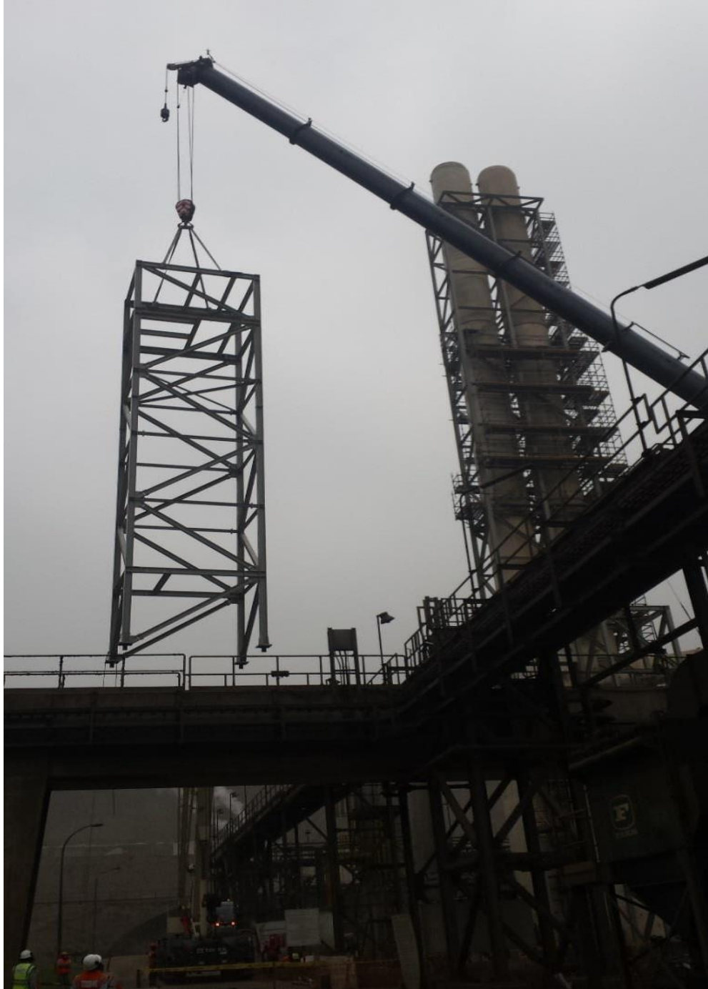
FIGURA N°11 IZAJE DE COLUMNAS INICIO
