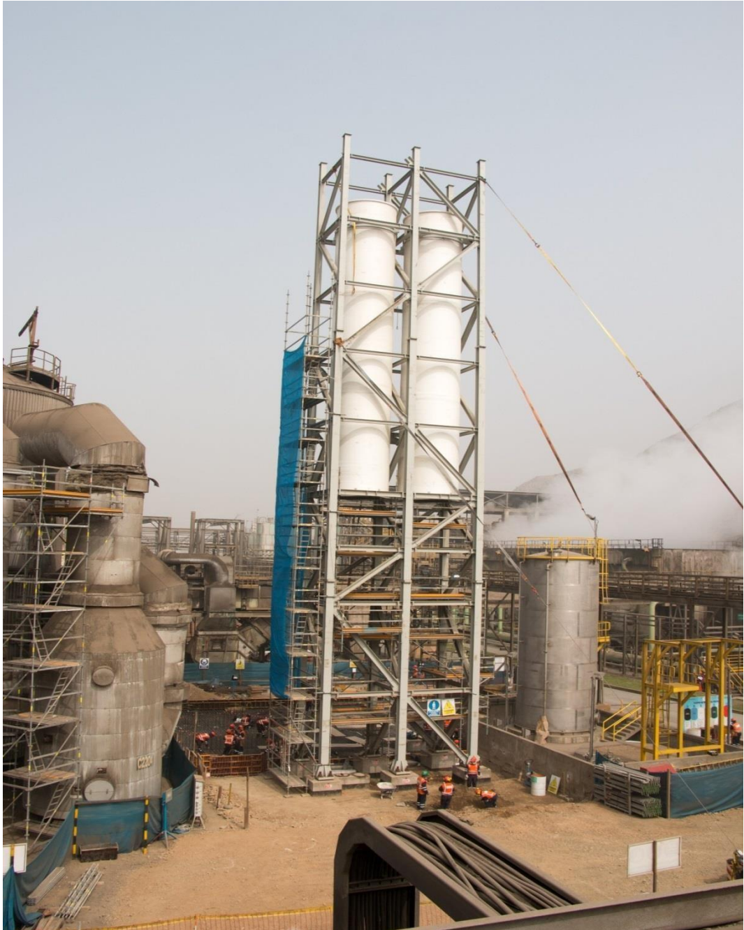
FIGURA N°13 IZAJE DE COLUMNAS FINAL
