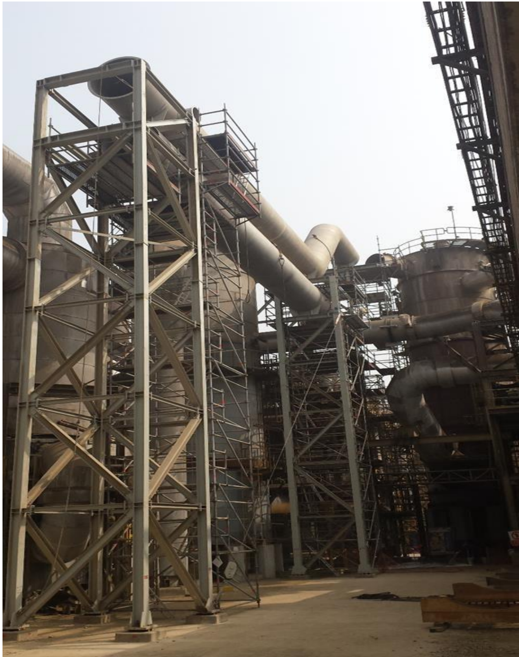
FIGURA N°24 MONTAJE DE TUBERIAS
