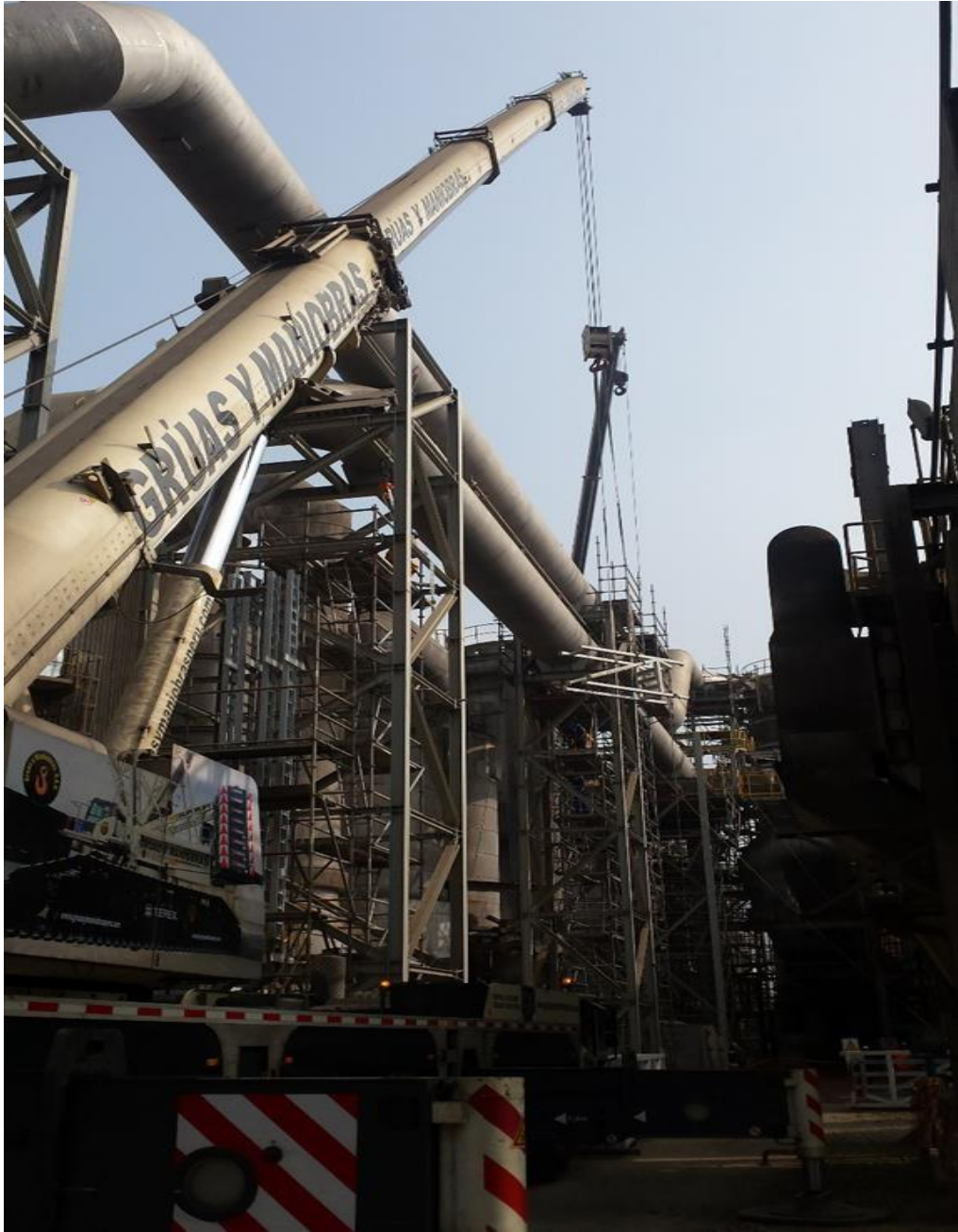
FIGURA N° 23 MONTAJE DE TUBERIAS
