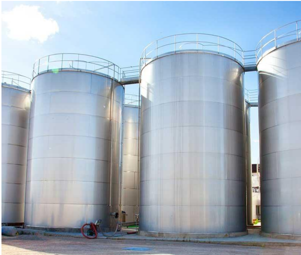
FIGURA N° 5 TANQUES VERTICALES DE ALMACENAMIENTO DE ACIDO DEBIL
