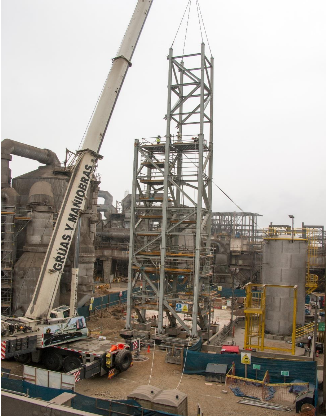
FIGURA N°12 IZAJE DE COLUMNAS INTERMEDIO
