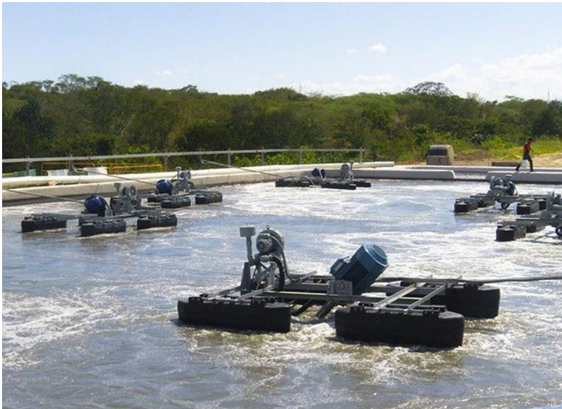
Fig.Nº19: Proceso de Aireación
