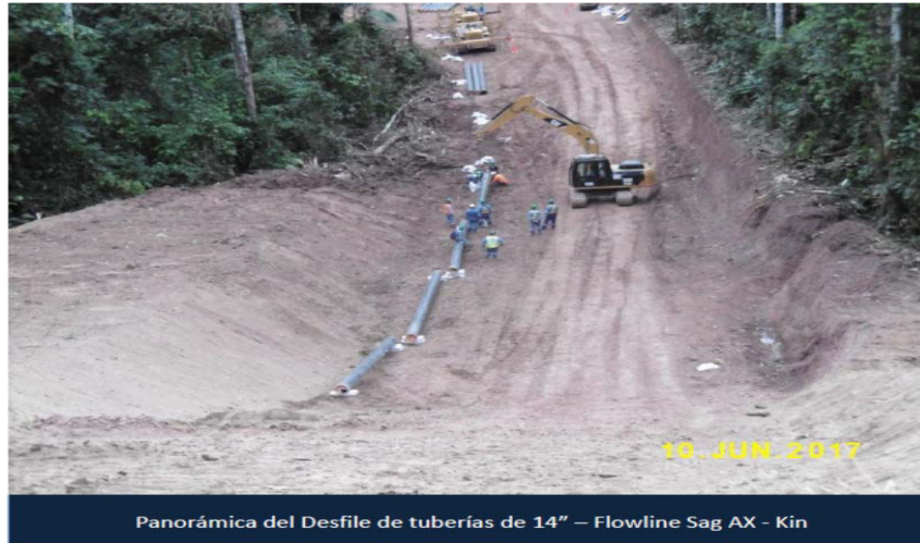
Figura N° 2.37 Desfile de tubería
