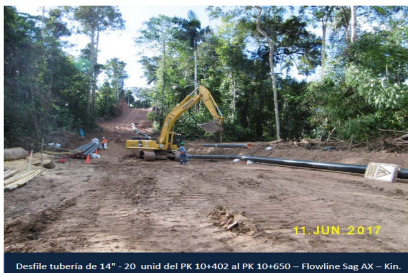
Figura N° 2.36 Desfile de tubería
