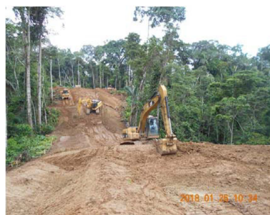
Conformación de cortacorrientes - cierre del DDV Sagari BX - Sagari AX
