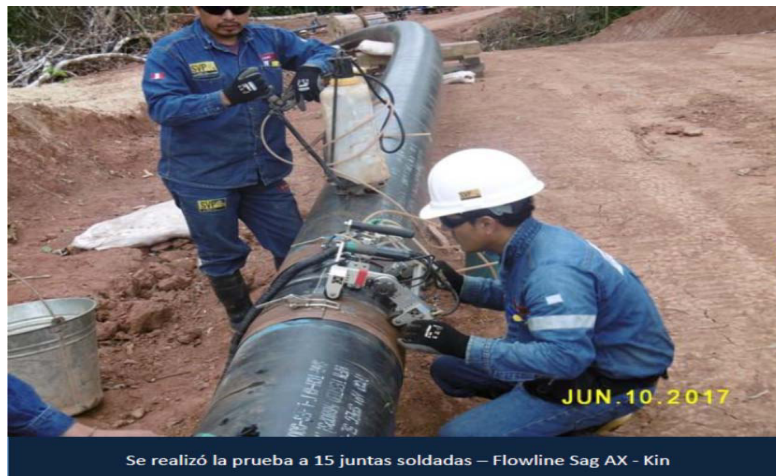
Figura N° 2.41 Ensayos de ultrasonido
