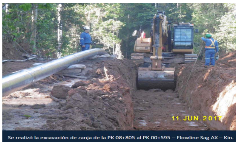
Figura N° 2.31. Trabajos de excavación
