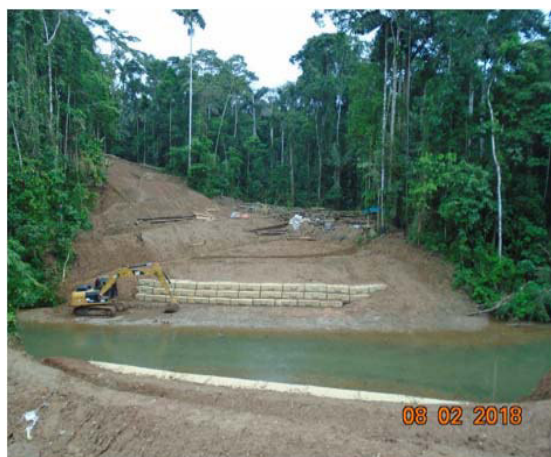
Colocado de hydroblocks - cierre del DDV Sagari AX - Kinteroni
