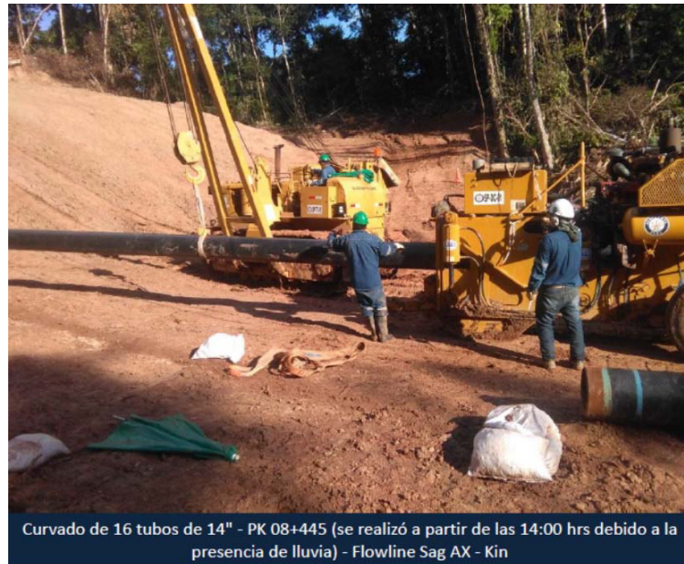
Figura N° 2.40. Curvado de tubos
