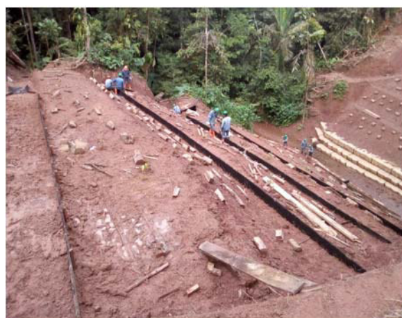
Construcción de trincheras - cierre del DDV Sagari AX - Kinteroni
