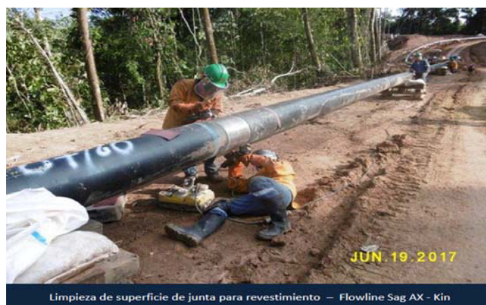
Figura 2.44 Limpieza de superficie
