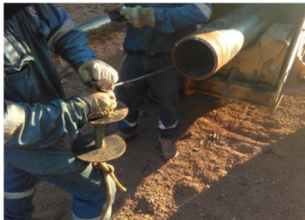
Figura N° 2.39. Inspección de curvado.
