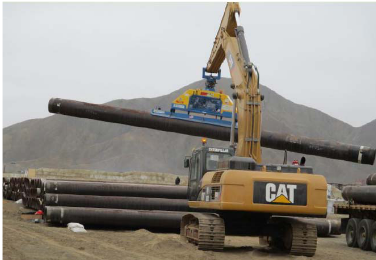
Figura N° 2.7 Izaje de la tubería con Vacuwok
