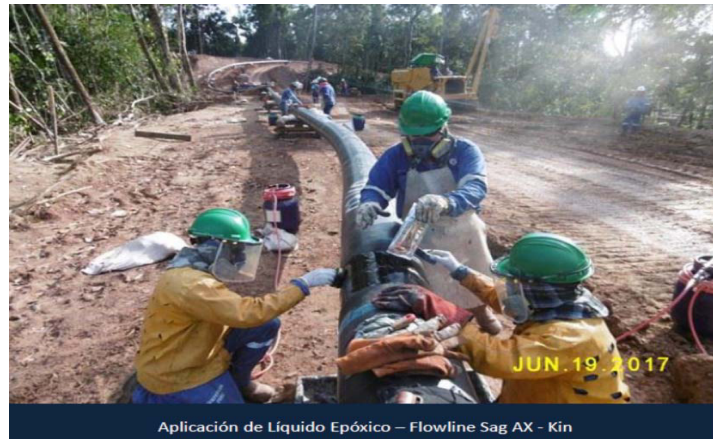
Figura 2.45 Aplicación del Líquido Epóxico e Instalación de la Manta.
