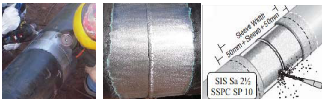
Figura N° 2.17. Preparación de la superficie del tubo
