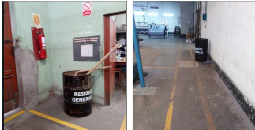
Inspección de Tachos de residuos sólidos
