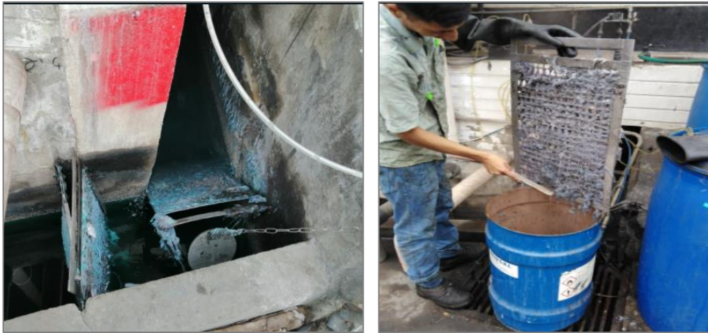
Figura 20 Limpieza del Tratamiento primario
