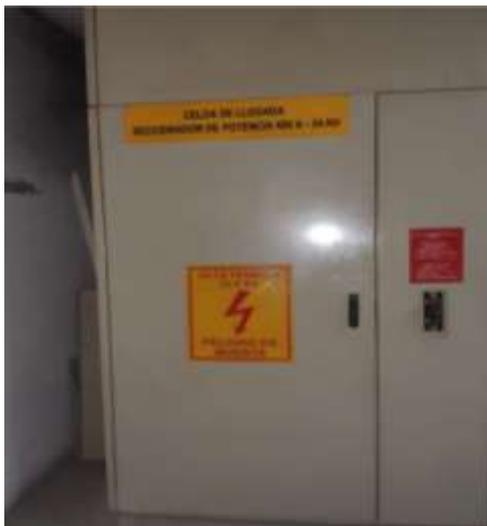
Foto 11. Sistema de Llegada con Equipo de protección, Seccionador de Potencia
