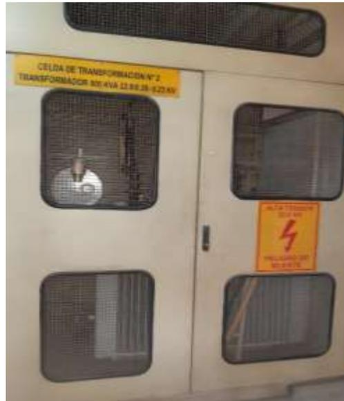
Foto 10. transformador N° 2 en aceite con aislamiento bajo
