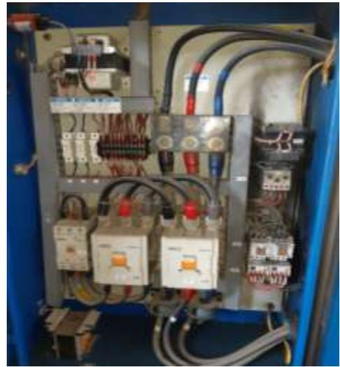
*Foto 2.* Tablero en B.T. para señal de arranque
