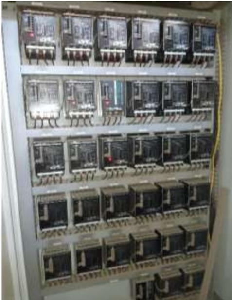
*Foto 15.* Interruptores de B.T. No cuenta con regulación ante Sobrecargas y Cortocircuito
