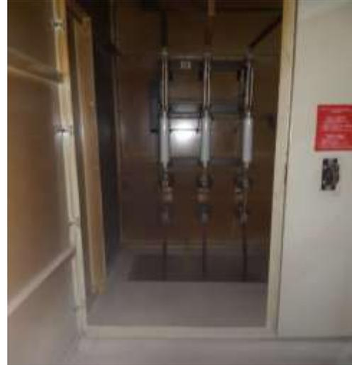
*Foto 14.* Seccionador de Potencia con 30 años de operación, aislamiento bajo
