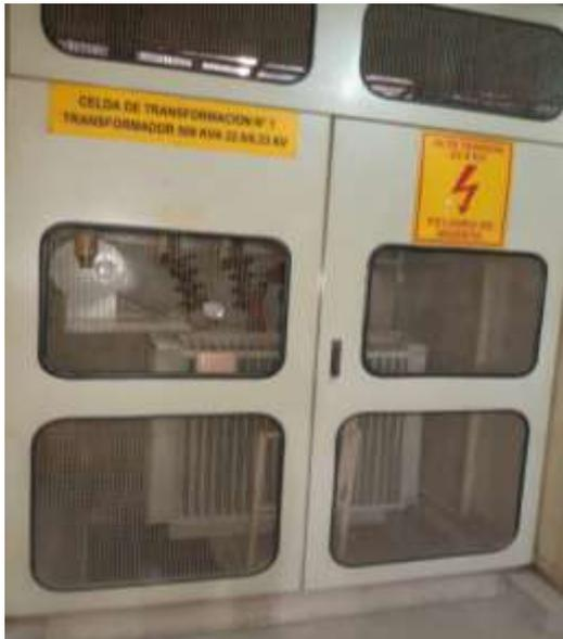
Foto 9. Transformador N° 1 en Aceite, con aislamiento bajo
