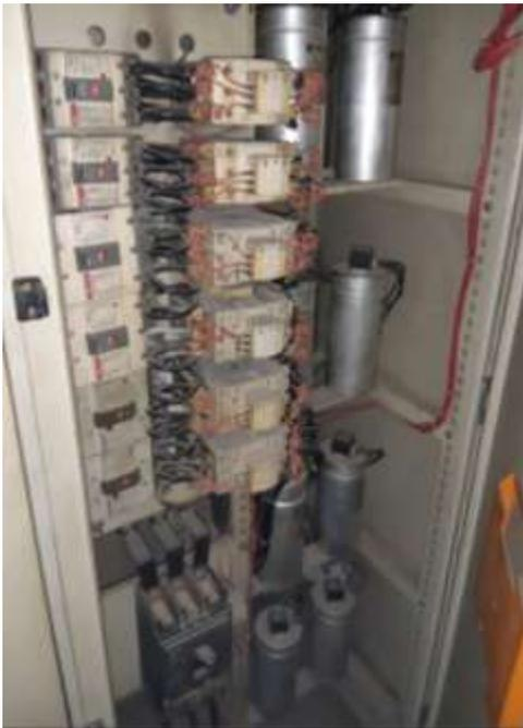
*Foto 5.* Sistema de compensación por condensadores
