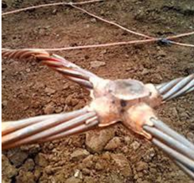
Unión de conductores para malla del sistema de puesta a tierra
