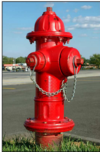
Figura 2.10 Hidrante contra incendio tipo húmedo
