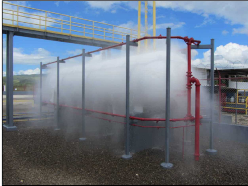
Figura 2.6 Sistema de extinción por enfriamiento
