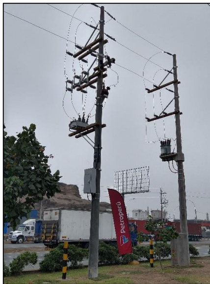
Figura 2.2 - Punto de Medición a la Intemperie (PMI)
