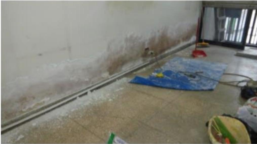
Imagen N° 3: Se evidencia que los pisos del almacén están deteriorados y las paredes no son lisas.
