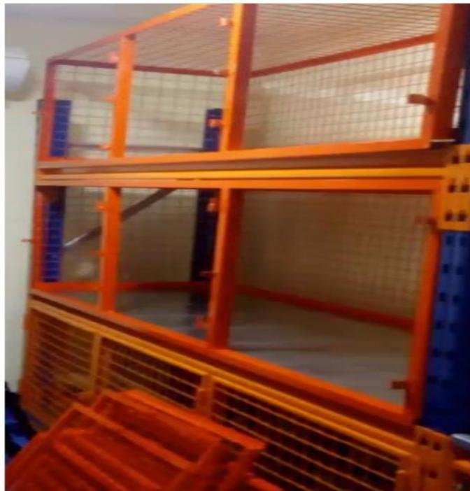
Figura Nº 7: Diseñando las áreas de Devolución, Contramuestras y Bajas / rechazados; las mismas que deben estar separadas de las demás áreas, con enmallado y agujero para el respectivo candado.
