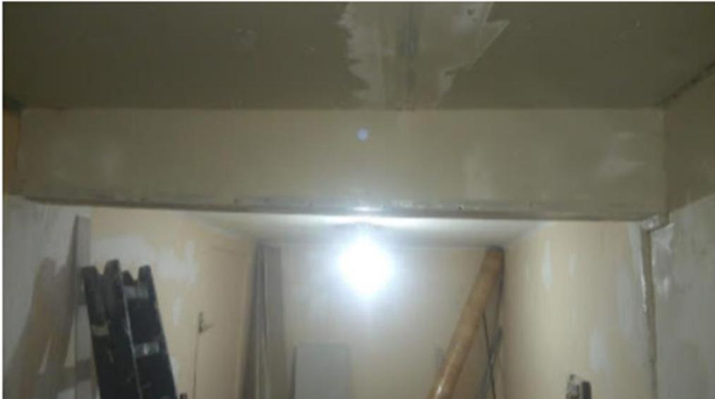
Imagen N° 4: El techo y las paredes no son lisos, las luminarias no son las adecuadas para un almacén de droguería
