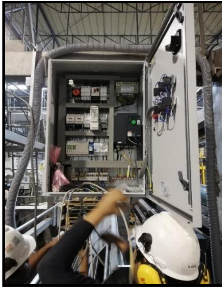
Foto 3.10: Conexión de tablero
