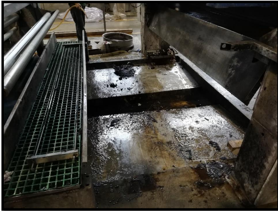
Foto 3.8: Piso instalación tina lavado Bianco
