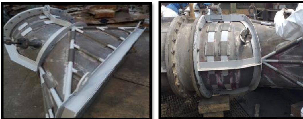
Figura 39. Montaje del ducto de salida
