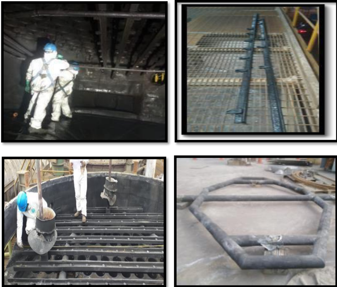
Figura 27. Retiro de estructura interna EFH
