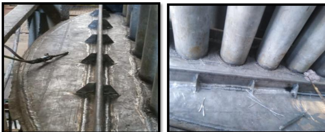
Figura 31. Reparación techo espejo inferior (externo)
