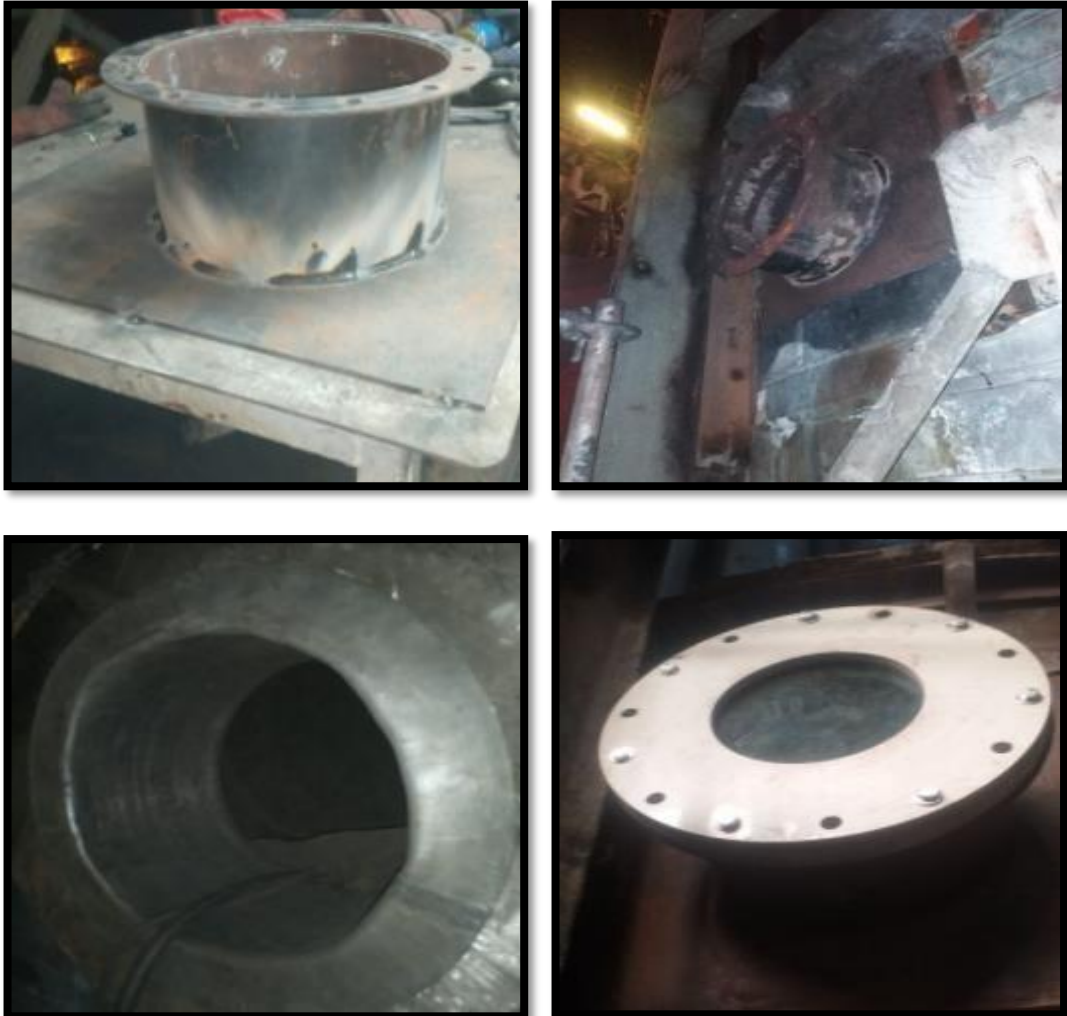
Figura 28. Montaje de manhole lateral EFH
