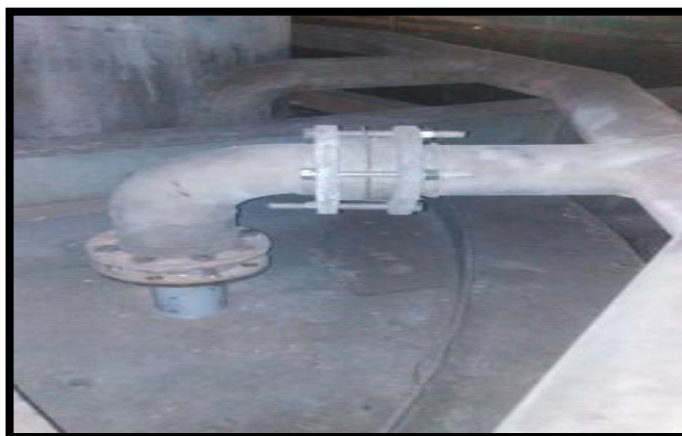
Figura 37. Montaje de sistema de inyección y drenaje del EFH
