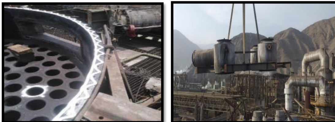
Figura 36. Montaje de techo del EFH
