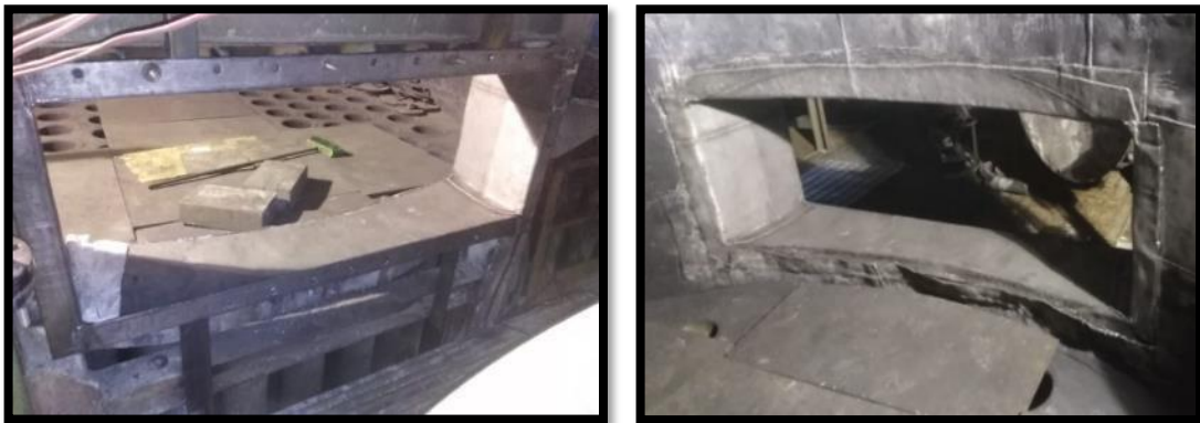
Figura 34. Reparación de marco del ducto de salida (terminado)
