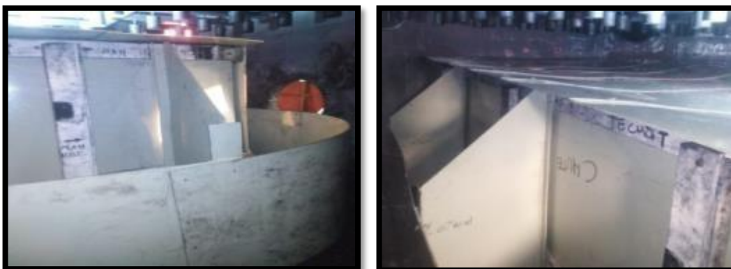
Figura 40. Montaje del ducto de salida
