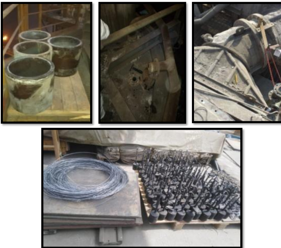
Figura 24. Retiro de aislador, electrodos y contrapesas
