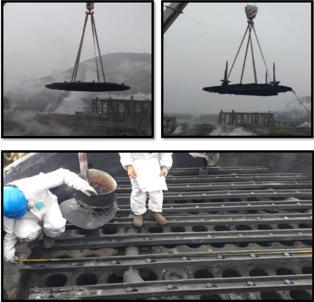
Figura 25. Retiro de techo de EFH
