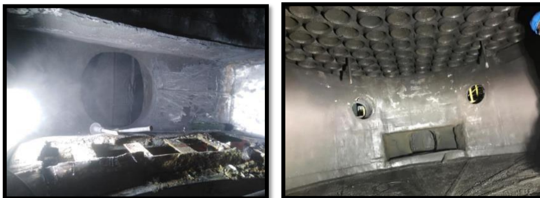
Figura 35. Reparación ducto de ingreso del EFH
