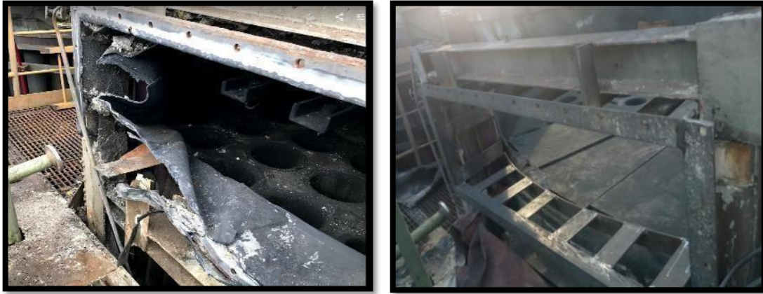
Figura 33. Reparación del marco, ducto de salida
