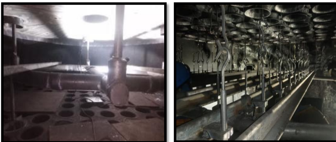
Figura 38. Alineamiento de electrodos y pesas
