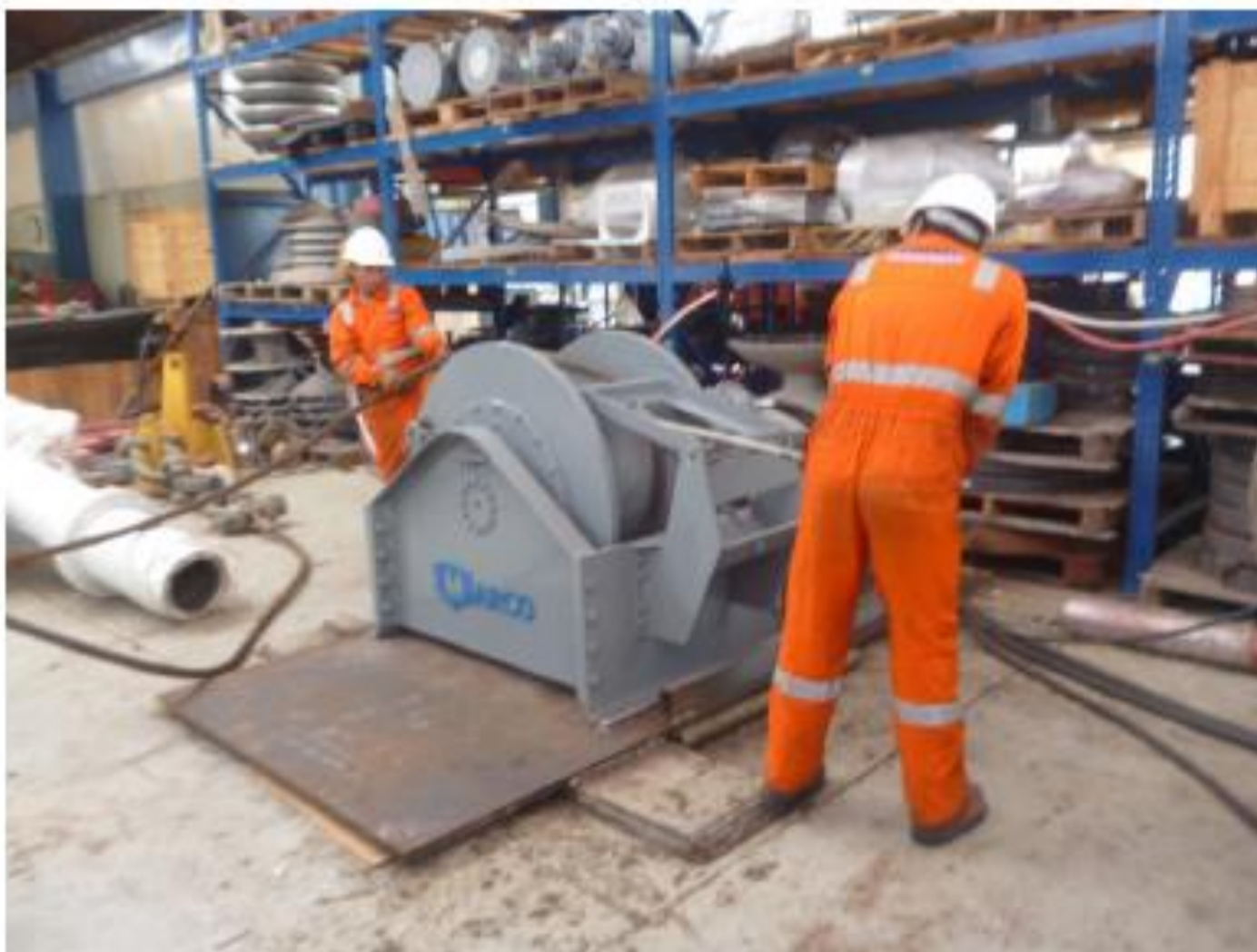
Fig. 6: Personal Técnico instalando componentes para la prueba.
