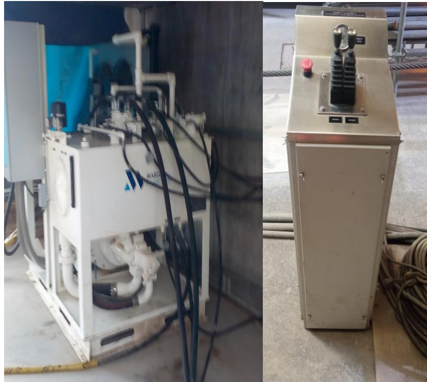
Figura 4. 3. Montaje de Unidad Hidráulica. Tomado de “Elaboración propia”
