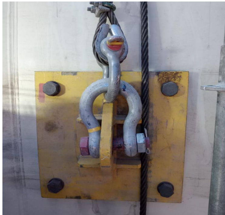
Figura 4. 1. Instalación de Oreja de Izaje. Tomado de “Elaboración propia”
