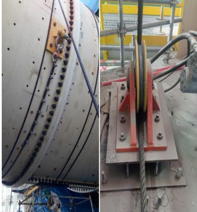
Figura 4. 2. Instalación de Cables. Tomado de “Elaboración propia”
