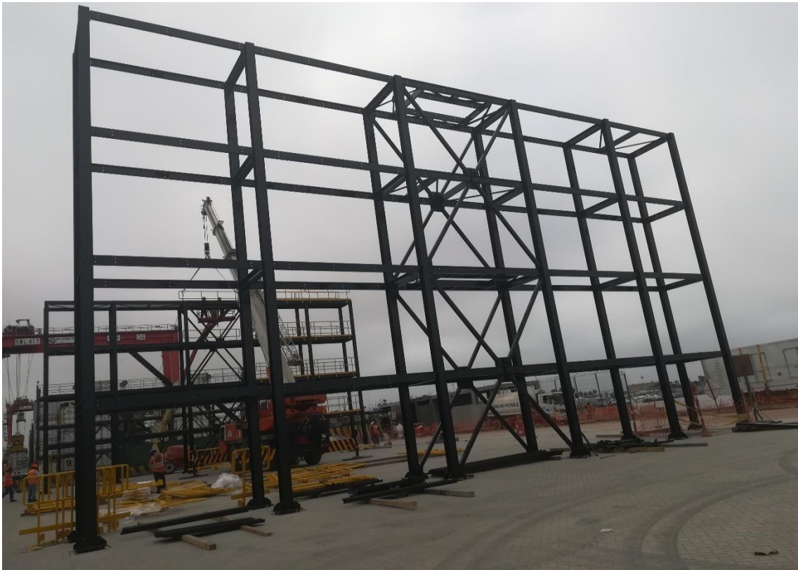
Imagen 26: Instalación de Vigas de amarre
