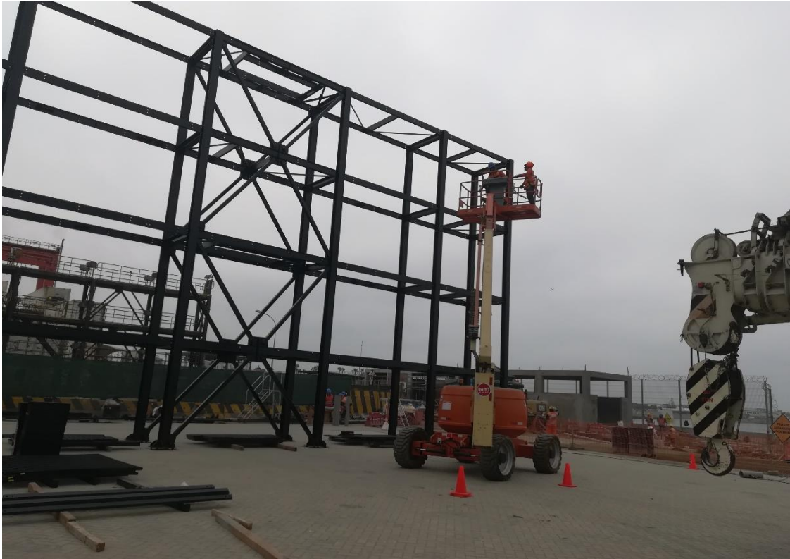
Imagen 27: Instalación de Viguetas y Diagonales
