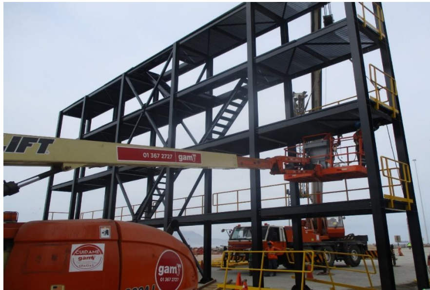
Imagen 30: Instalación de graiting y baranda
