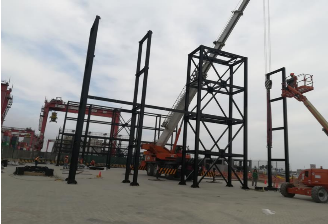
Imagen 25: Montaje de viga de amarre
