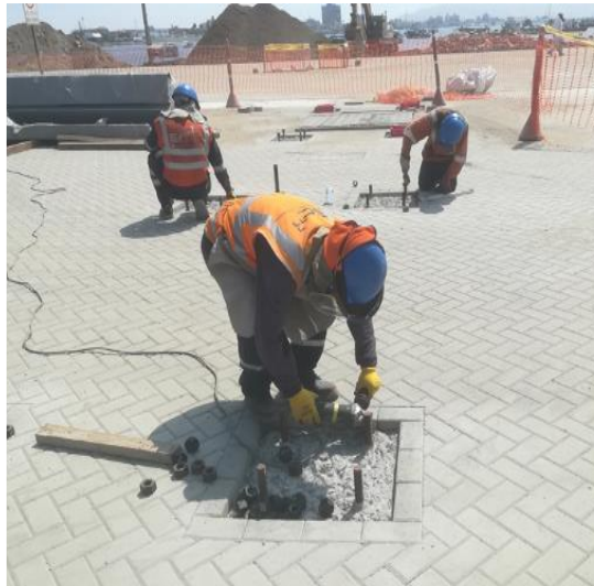
Imagen 18: Limpieza de perno de anclaje
