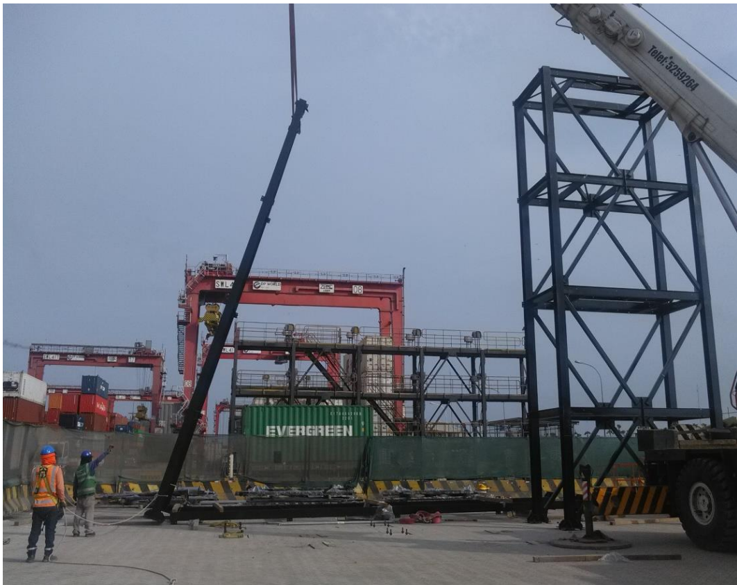
Imagen 24: Montaje pórtico concéntrico
