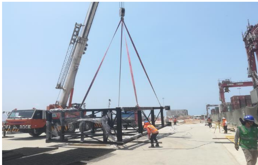
Imagen 21: Descarga del pórtico rígido
